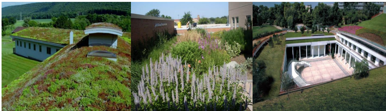
Εικόνα 1.11. Εκτατικού τύπου φυτεμένο δώμα (αριστερά). Ημιεντατικού τύπου φυτεμένο δώμα (κέντρο). Εντατικού τύπου φυτεμένο δώμα στο Μέγαρο Μουσικής Αθηνών (δεξιά). [Πηγή: Περγαλιώτη, Ν. 2010. Διερεύνηση της επίδρασης του είδους και του βάθους του υποστρώματος καθώς και της συχνότητας άρδευσης στην ανάπτυξη των ξηροφυτικών ειδών Helichrysum Italicum και Helichrysum Orientale σε συνθήκες φυτοδώματος.]
