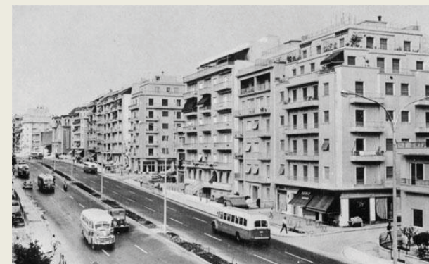
Οι πρώτες πολυκατοικίες επί της όδου Κηφισίας
