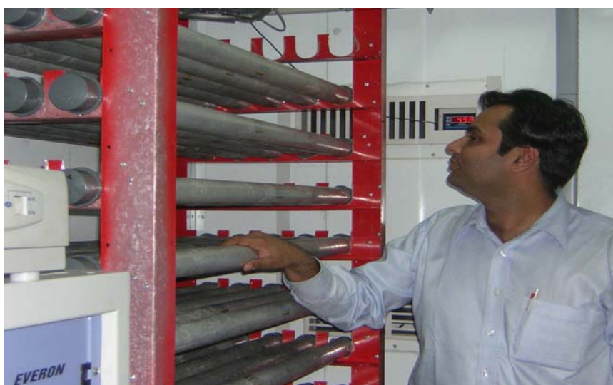
Σχήμα 6.19. Συσκευασίες υλικών αλλαγής φάσης που χρησιμοποιούνται σε τηλεπικοινωνιακά κουβούκλια
