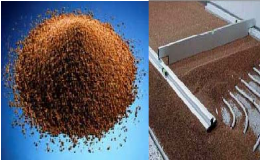
Σχήμα 6.15. Κόκκοι και διάταξη υλικών αλλαγής φάσης για αντικατάσταση θερμομπετόν σε εγκατάσταση ενδοδαπέδιας θέρμανσης
