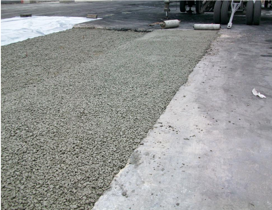
Φωτογραφία 3.5 Τελική μορφή επιφάνειας πορώδους σκυροδέματος
