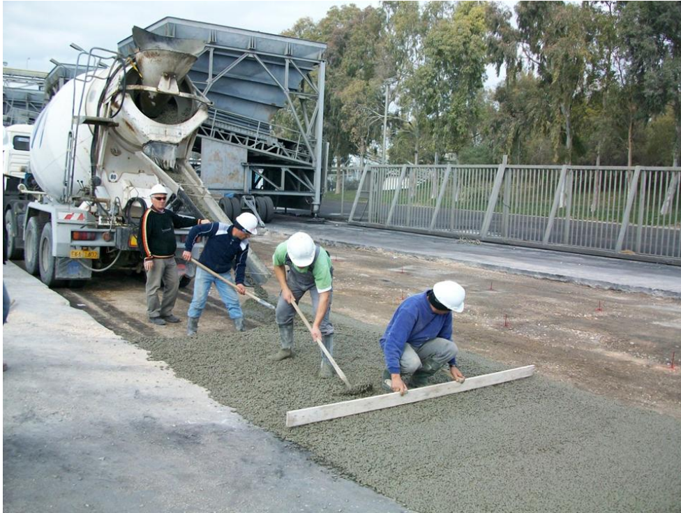
Φωτογραφία 3.3 Τοποθέτηση πορώδους σκυροδέματος
