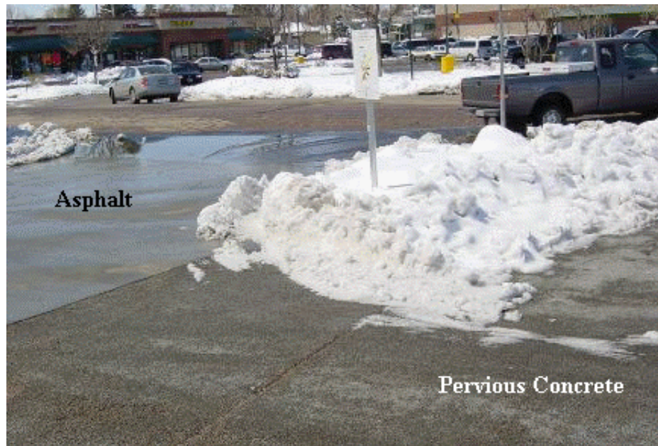
Φωτογραφία 3.2 Σύγκριση ασφάλτου και πορώδους σκυροδέματος
