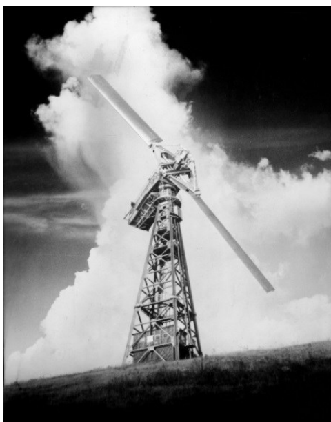
Εικ. 3.6 Η πρωτοποριακή πειραματική ανεμογεννήτρια των Smith-Putnam – Η πρώτη αιολική εγκατάσταση ισχύος MW [Πηγή: Wind-works by Paul Gipe –Smith-Putnam Industrial Photos: http://www.wind-works.org ]
