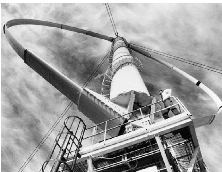
Εικ. 3.7 Η ύψους 34 μέτρων ανεμογεννήτρια τύπου Darrieus που αναπτύχθηκε από το Sandia National Laboratory στο New Mexico [Πηγή: http://www.techniklexikon.net/d/darrieus-rotor/ ]
