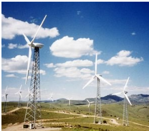
Εικ. 3.9 Αιολικό πάρκο ανεμογεννητριών τύπου ZOND Z-40 συνολικής ισχύος 600 kW στο Τέξας των Η.Π.Α. [Πηγή: «The illustrated history of wind power development», U.S. Federal Wind Energy Program: http://www.telosnet.com/wind/ , 2006 »]
