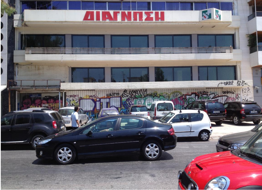
Εικόνα 2.2: Νοτιοδυτική όψη κτιρίου
