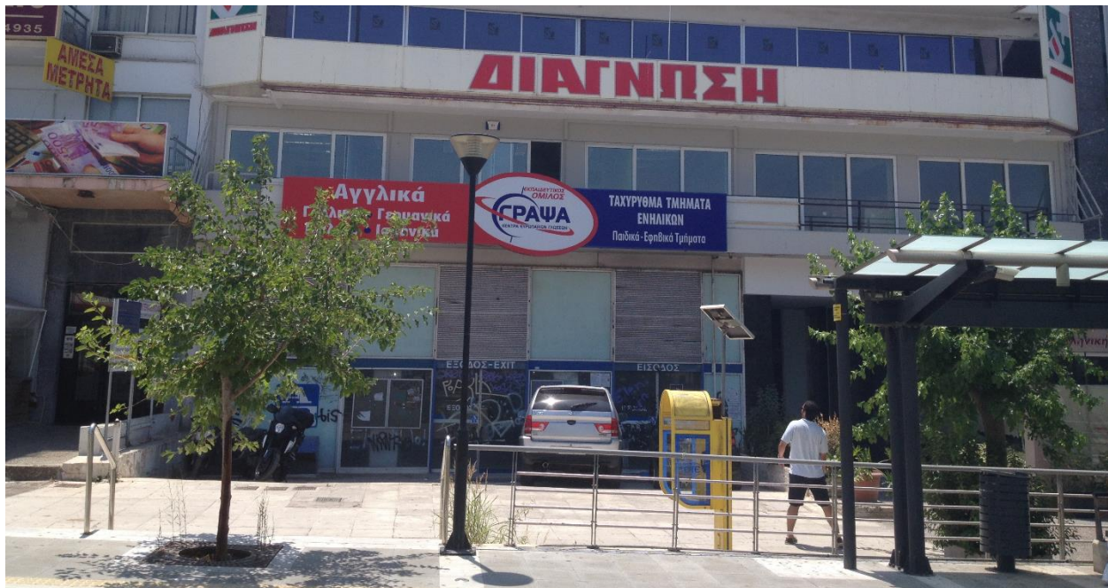
Εικόνα 2.1: Βόρεια όψη κτιρίου
