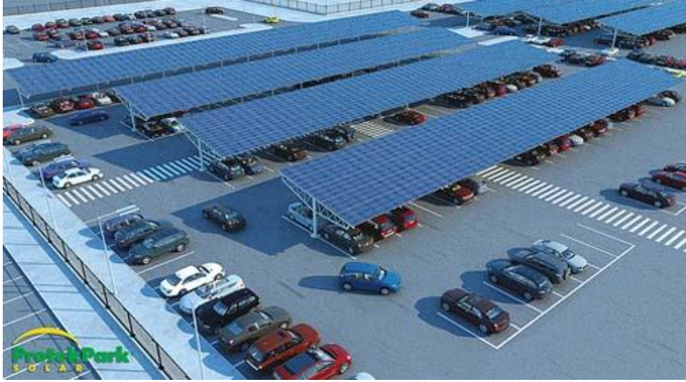
Εικόνα 1.8: Στέγαστρα με φωτοβολταϊκά σε χώρο στάθμευσης (πηγή: http://solarenergy.gr/images/uploads/solar_parking_shades_solarenergy.jpg )
