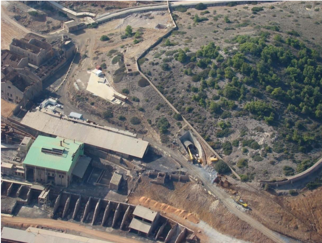
Εικόνα 3.2: Περιοχή κατασκευής του υπόγειου χώρου (Μπενάρδος, 2010)
