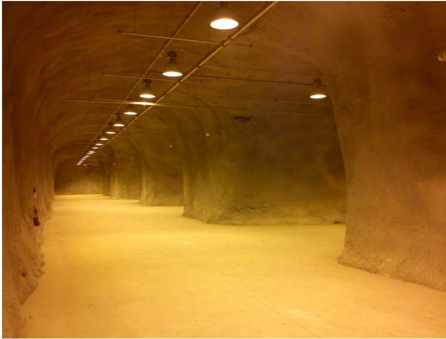
Εικόνα 3.3: Άποψη του υπόγειου χώρου στην τελική φάση
