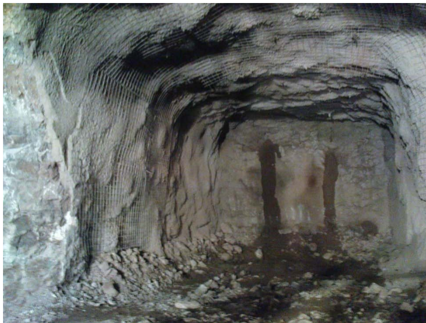
Εικόνα 3.5: Συνάντηση σήραγγας προσπέλασης με υπόγειο χώρο (Μπενάρδος, 2009)
