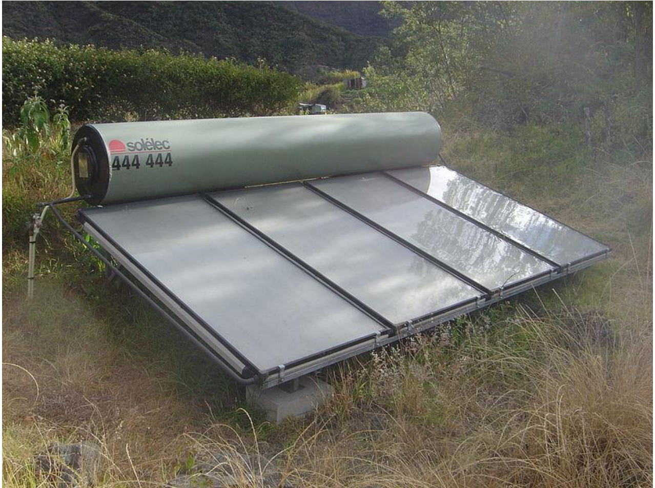
Εικ. 3.3 Ηλιακός Θερμοσίφωνας Πηγή: http://el.wikipedia.org/
