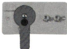
Σχήμα 6.3. Κομβιοδότης ασφαλείας χώρου φρεατίου.
