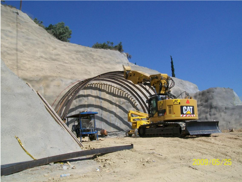
Εικόνα 5.7: Τοποθέτηση μεταλλικών προπλαισίων στο δεξιό κλάδο των ανατολικών στομιών
