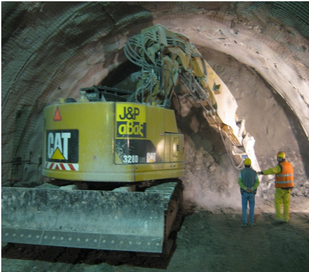
Εικόνα 4.1: Α' φάση εκσκαφής (ημιδιατομή)
