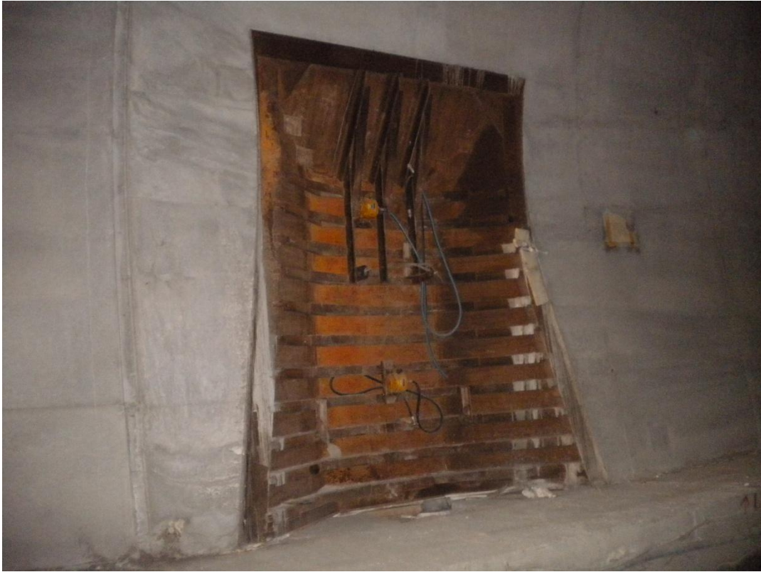
Εικόνα 6.3: Εσοχή στη μόνιμη επένδυση – αριστερός κλάδος (Οκτώβριος 2013)
