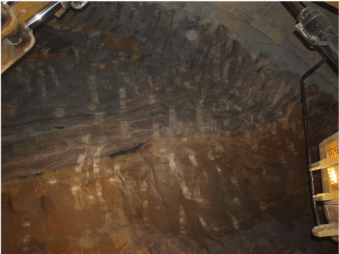
Εικόνα 6.29: Επαφή κυανής μάργας με ψαμμίτη (διακρίνονται λεπτές ενστρώσεις τύρφης)
