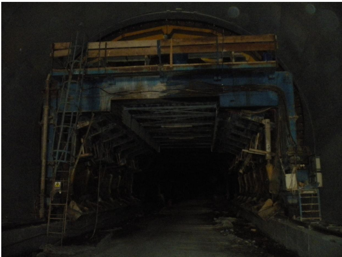
Εικόνα 6.2: Φορείο για την κατασκευή της μόνιμης επένδυσης – αριστερός κλάδος (Οκτώβριος 2013)
