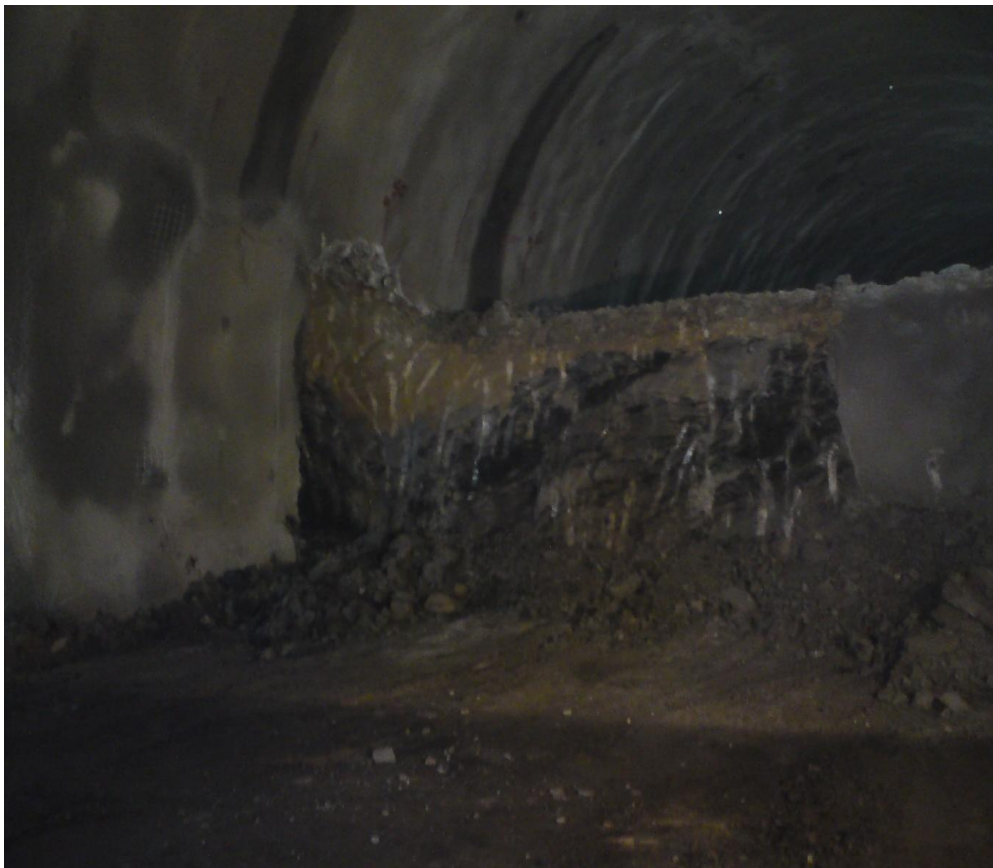
Εικόνα 4.2: Β' φάση εκσκαφής (η Α' φάση εκσκαφής έχει ολοκληρωθεί)
