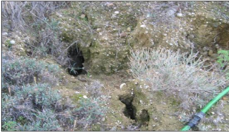
Εικόνα 2.12: Ανοικτές ρωγμές κατάντη της γεώτρησης 56ΓΝ3 που σχηματίζουν την στέψη μίας νέας κατολίσθησης
