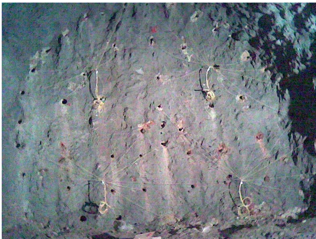
Εικ. 77: Σήραγγα Πλατάνου. Διάταξη εκρηκτικών
