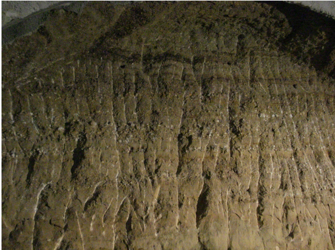
Εικ.16: Χαλικώδης φάση στη σήραγγα της Τράπεζας.
