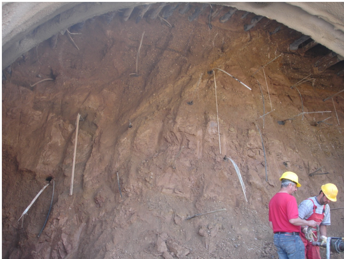
Εικ. 76: Αγκύρια Fiberglass συγκράτησης μετώπου σήραγγας Τράπεζας
