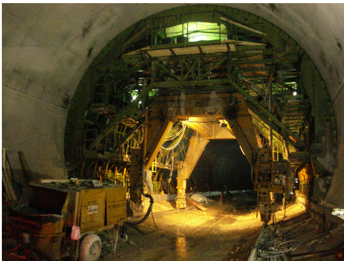
Εικ. 80: Εργασίες μόνιμης επένδυσης σήραγγας Τράπεζας
