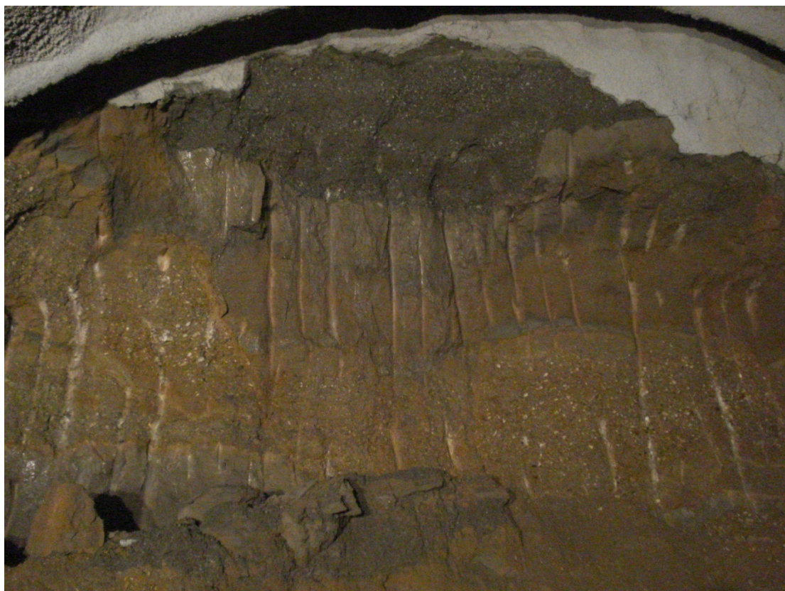
Εικ.23: Κορήματα που υπερκείνται μαργών με χαλικώδεις ενστρώσεις
