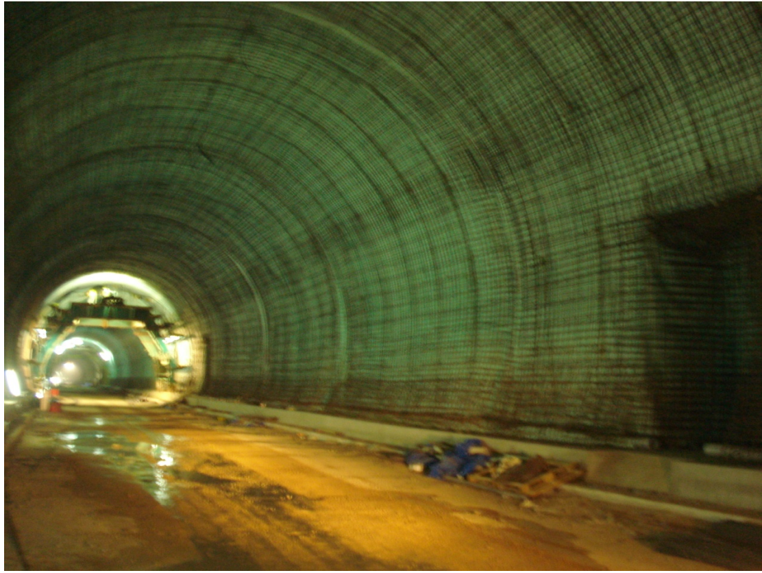
Εικ. 81: Οπλισμός και στεγάνωση σήραγγας Τράπεζας
