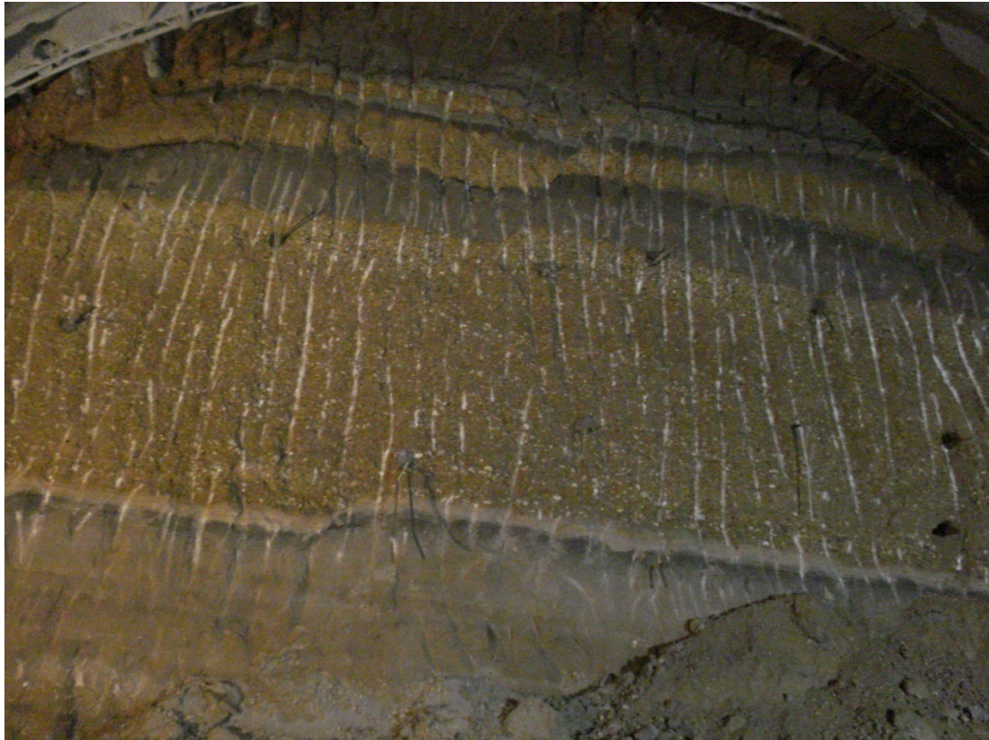
Εικ.20: Υπερκείμενες μάργες που εναλλάσσονται με κροκαλοπαγή.
