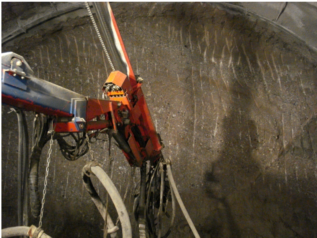
Εικ.17 Χαλικώδης φάση στη σήραγγα της Τράπεζας .
