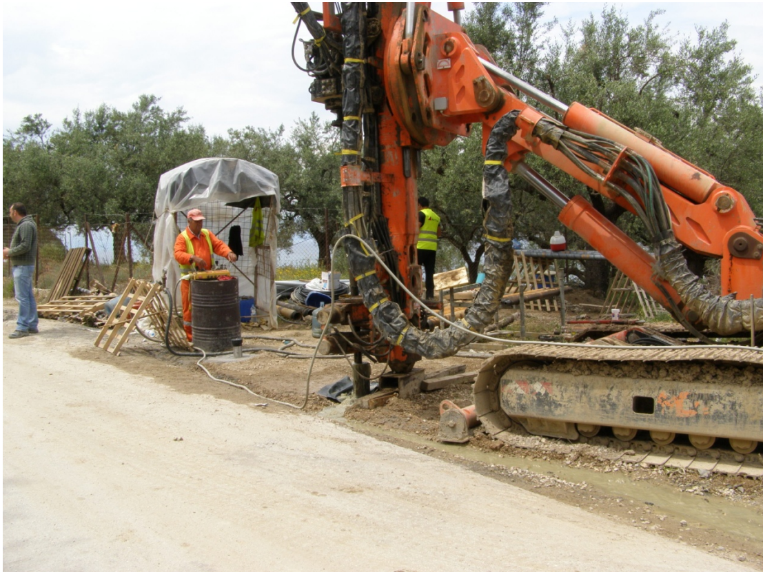
Εικ. 33: Γεωτρύπανο κατά την διάτρηση εγκατάστασης κλισιομέτρου.
