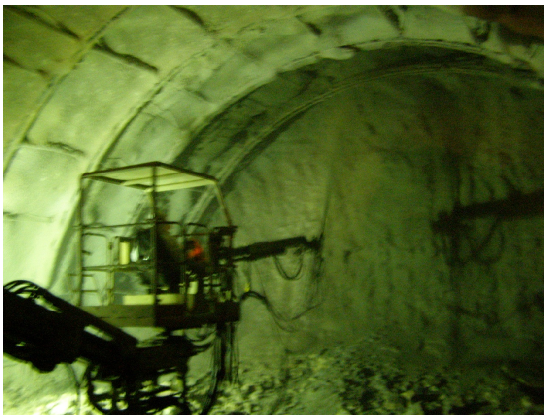
Εικ. 78: Εφαρμογή εκτοξευόμενου σκυροδέματος
