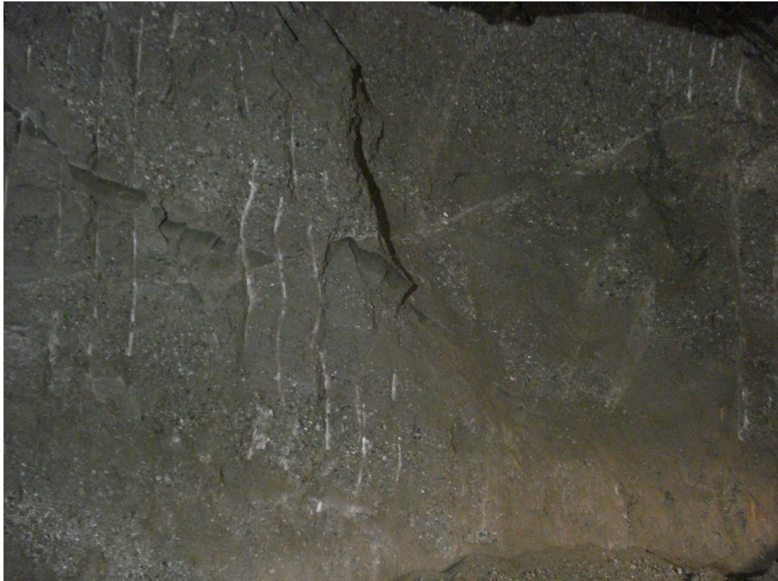
Εικ.18: Χαλικώδης φάση στη σήραγγα της Τράπεζας .
