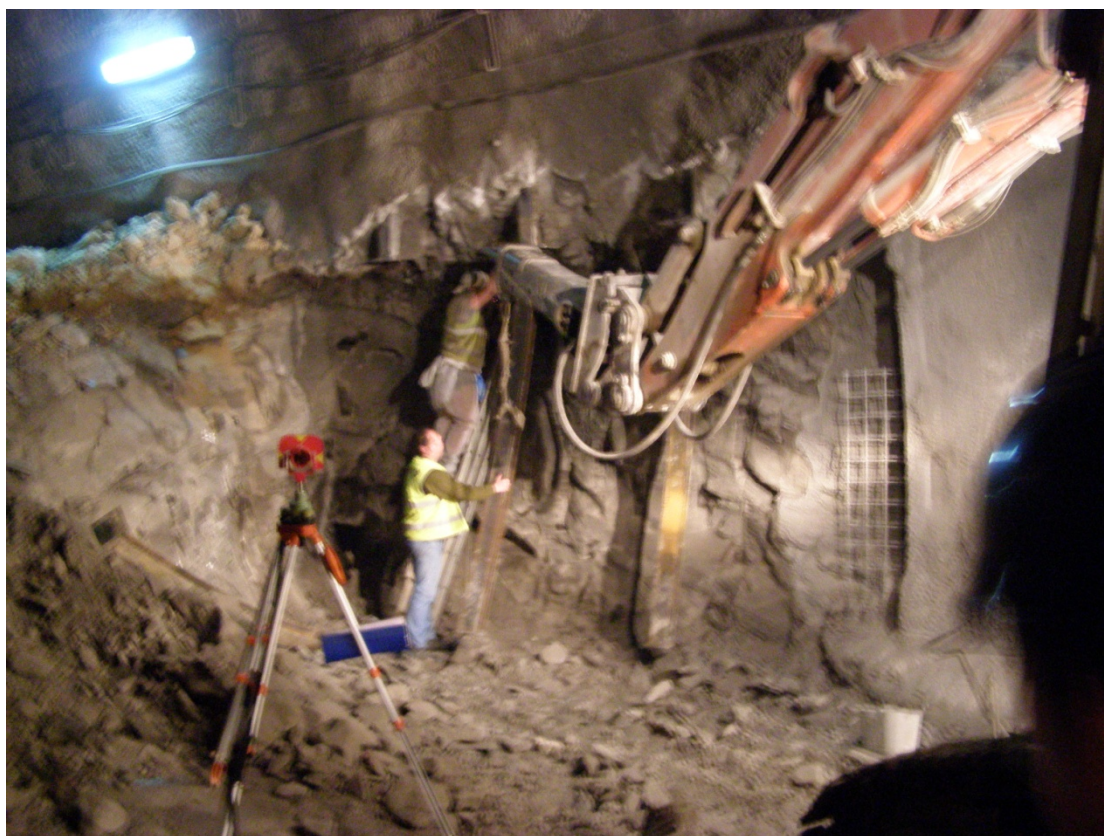
Εικ. 79: Σήραγγα Πλατάνου. Τοποθέτηση πλαισίων β' φάσης
