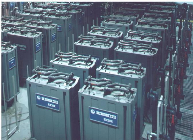
Σχήμα 2.3.9 Εγκατάσταση ηλεκτροδιάλυσης
