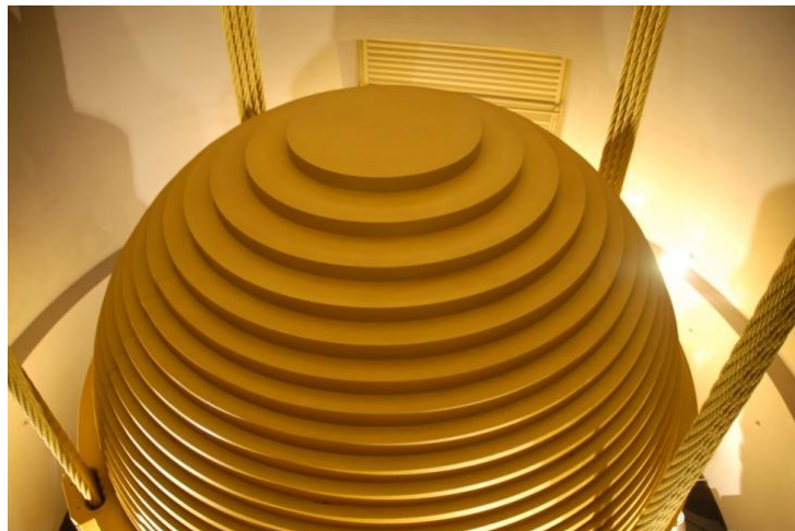
Εικόνα 1.18 Αποσβεστήρας μάζας του κτιρίου βάρους 728 τόνων.
