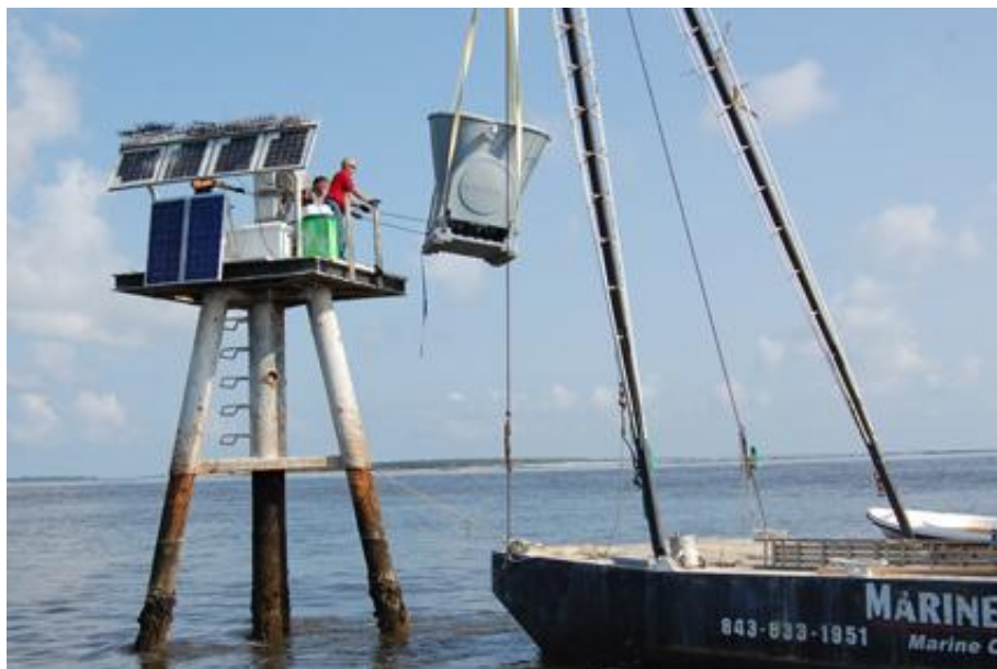
Εικόνα 2. 5. Τοποθέτηση συσκευής SoDAR σε πλατφόρμα ανοικτά των ακτών Georgetown , Βόρεια Καρολίνα.
