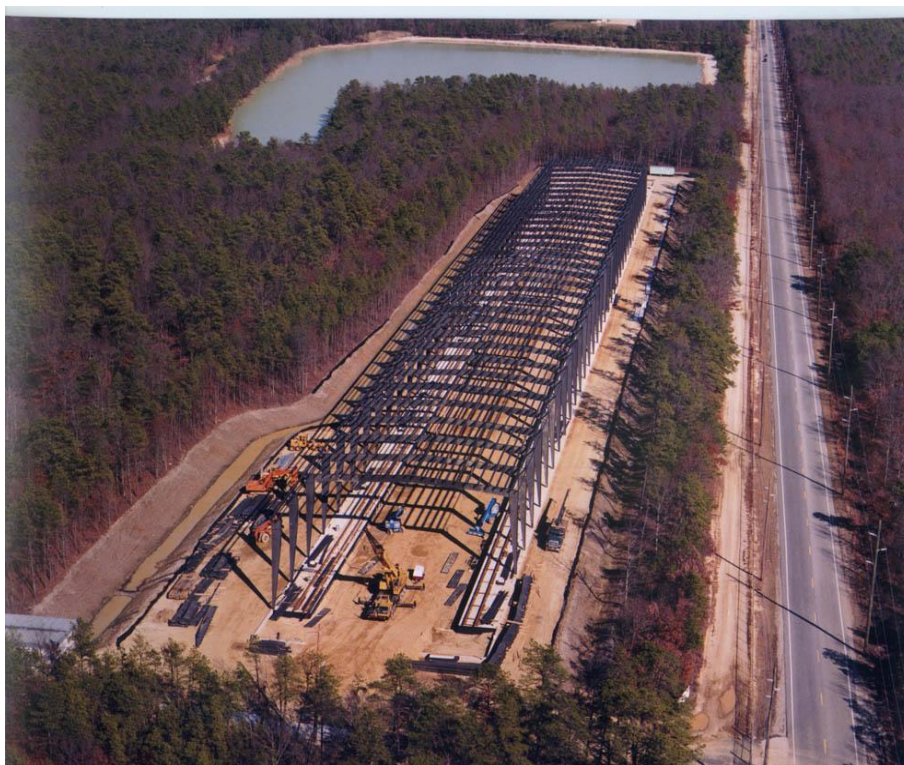
Εικόνα 5.1 Η υπό ανέγερση εγκατάσταση National Airport Pavement Test Facility (NARTF)
