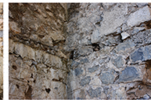
Υποδοχίς ξύλινων δοκών στη λιθοδομή
