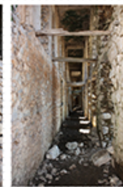
Ξύλινα δοκάρια στο διάδρομο
