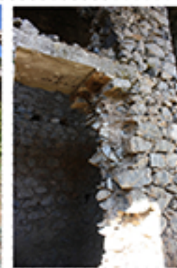
Αυτίλι από επλασμένο σκυρόδεμα
