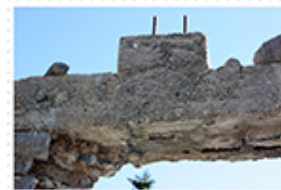
Απομεινός οπλισμών για στήριξη της στέγης
