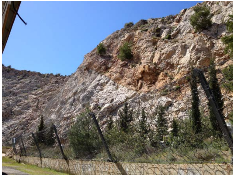
Εικόνα 56: : Πρανές στον Υμηττό
