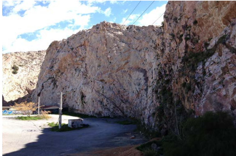
Εικόνα 57: Πρανές στον Υμηττό
