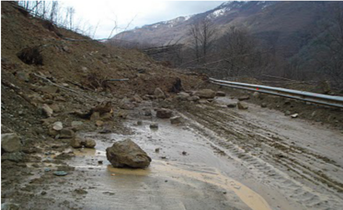
Εικόνα 3: Κατάπτωση μεγάλης μάζας βράχου στο οδικό δίκτυο των Ιωαννίνων
