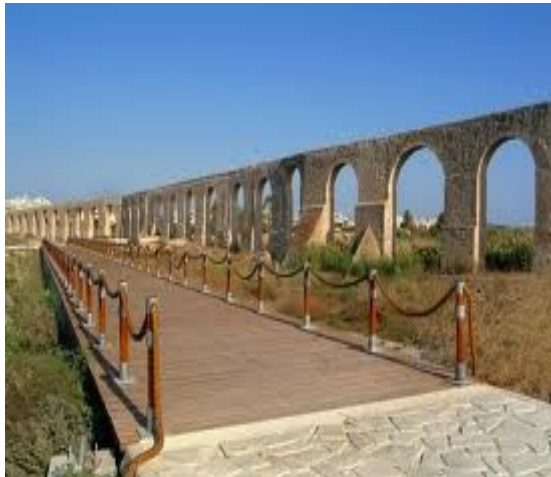
* Τμήμα του Υδραγωγείου Abu Bekir
