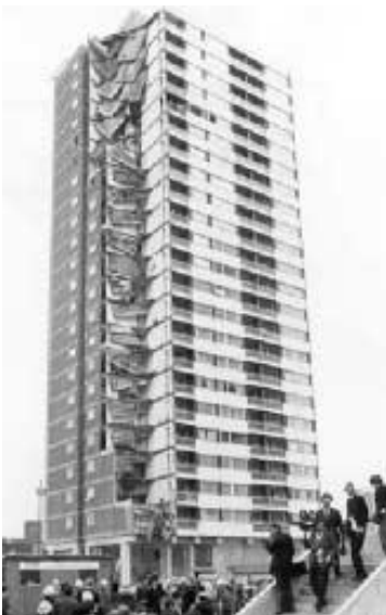
Εικόνα 10: Προοδευτική κατάρρευση του Ronan Point λόγω έκρηξης φυσικού αερίου
