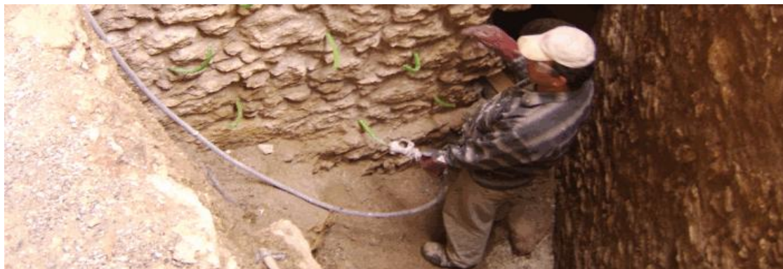
Εικόνα 5:Εισαγωγή ενέματος μέσω των σωληνίσκων
