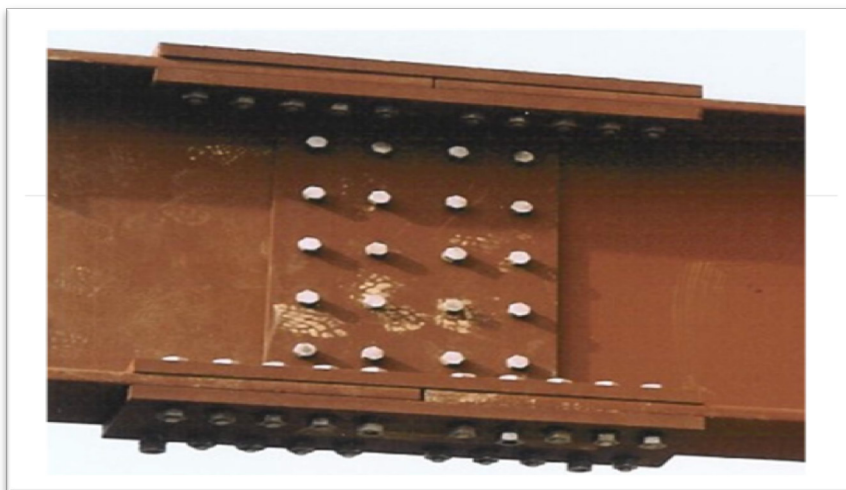
Σχ. 1.14 Αποκατάσταση συνέχειας μελών με λεπίδες
