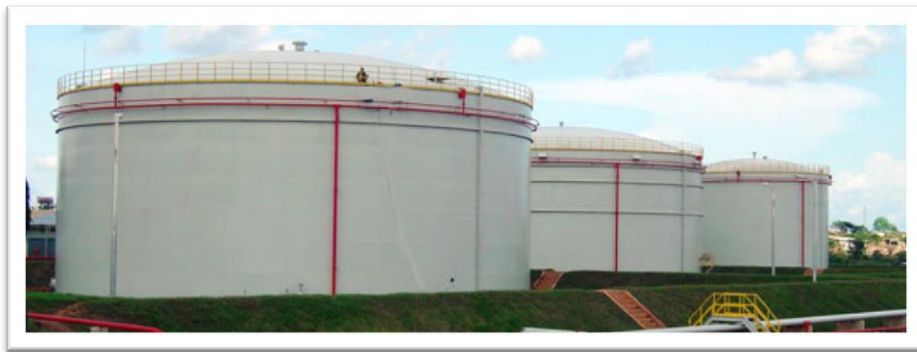
Φωτογραφία 6. Καθοδική προστασία σε βιομηχανική περιοχή [www.marpo.gr]
