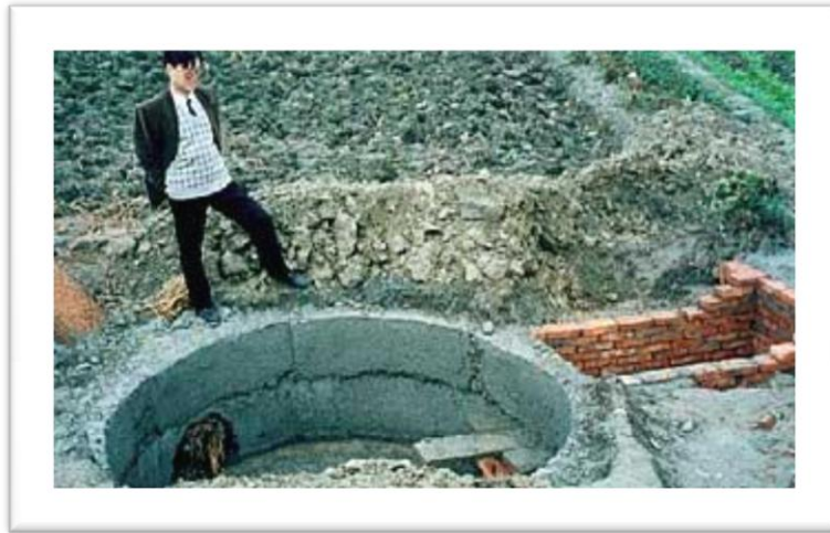
Εικόνα 23 : Σύστημα επεξεργασίας υπό κατασκευή.
