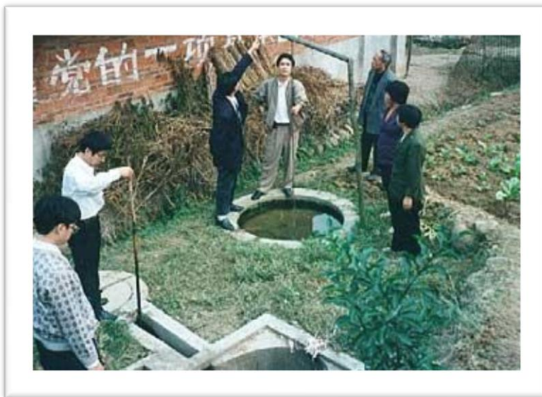
Εικόνα 24 : Κατασκευή του συστήματος από ειδικούς τεχνικούς.
