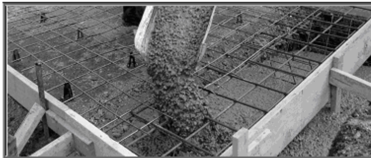
Εικόνα 1.27: Εφαρμογή τσιμέντου E-Crete™
