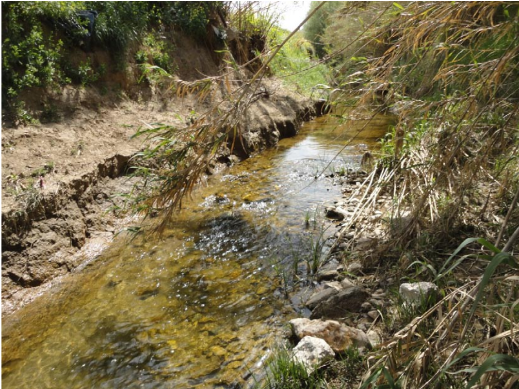
Σχήμα Π1.21: Φωτογραφική απεικόνιση της θέσης δειγματοληψίας RS14, όπου εμφανίζεται η έντονη βλάστηση και διάβρωση της κοίτης.
