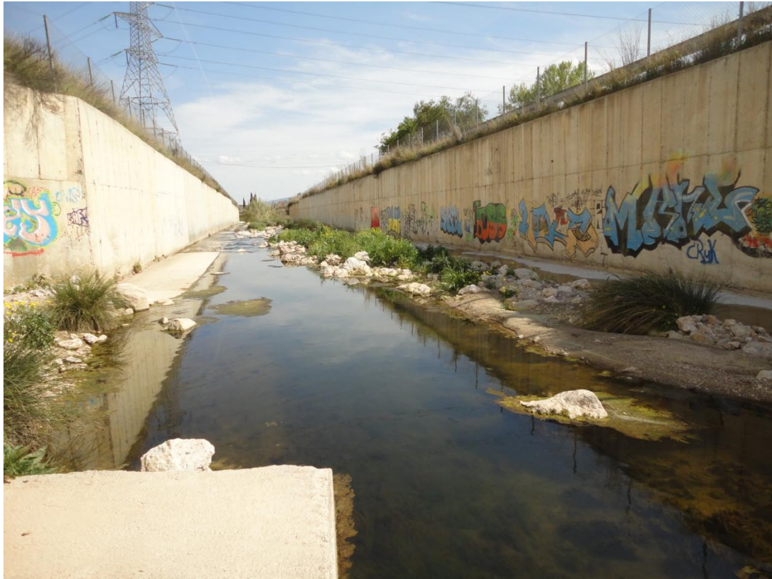
Σχήμα Π1.29: Φωτογραφική απεικόνιση της θέσης δειγματοληψίας RS20, στην οποία εμφανίζεται η διευθετημένη κοίτη, η έντονη βλάστηση και το ανθρακικό υλικό εντός αυτής.
