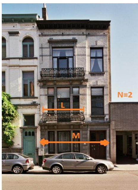
Εικόνα 4.44. Σε αυτή την εικόνα φαίνονται οι διαστάσεις που χρησιμοποιούνται στον παραπάνω τύπο για τον προσδιορισμό του ποσοστού του μήκους των εξωστών.[15]
