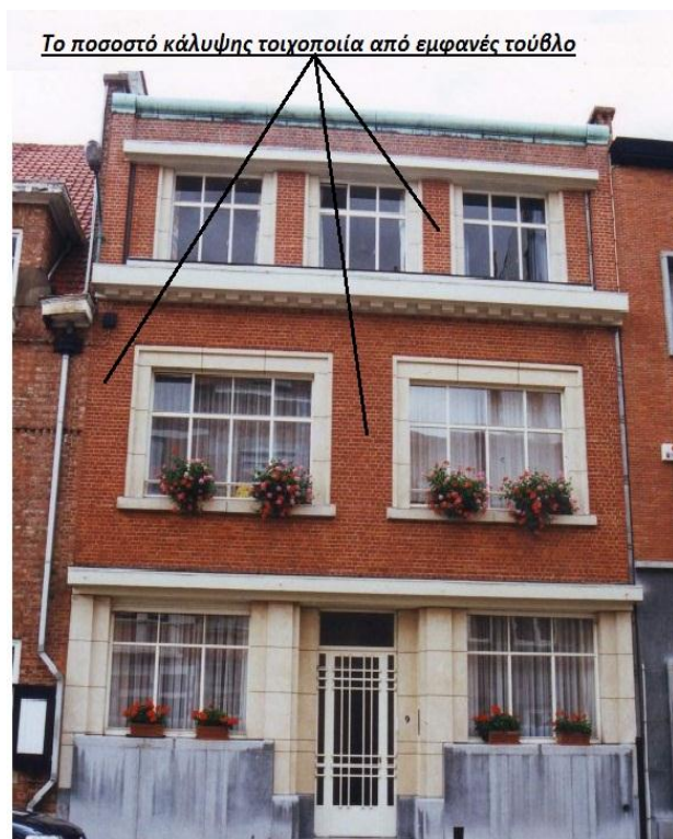
Εικόνα 4.28. Τρόπος καταγραφής του ποσοστού επιφάνειας πρόσοψης που αποτελείται από εμφανές τούβλο, σε σχέση με τα υπόλοιπα υλικά της συμπαγής τοιχοποιίας της πρόσοψης χωρίς τα ανοίγματα..[8]
