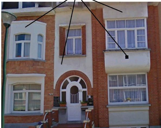
Εικόνα 4.31. Τρόπος καταγραφής του ποσοστού επιφάνειας πρόσοψης από σοβά, σε σχέση με τα υπόλοιπα υλικά της συμπαγής τοιχοποιίας της πρόσοψης χωρίς τα ανοίγματα.[9]
