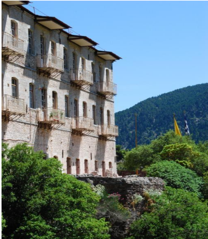
Εικόνα 2.17. Στην φωτογραφία αυτή βλέπουμε πως επηρεάζει το μήκος και το πλάτος του εξώστη στο ποσοστό της όψης που σκιάζεται από αυτόν. [ 20]
