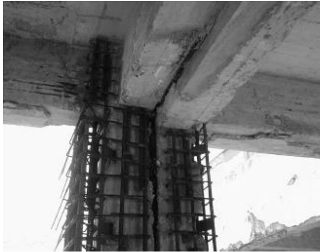
Σχήμα 5.4 Κατασκευή ανοικτού μανδύα υποστυλώματος στην περιοχή αντισεισμικού αρμού.
