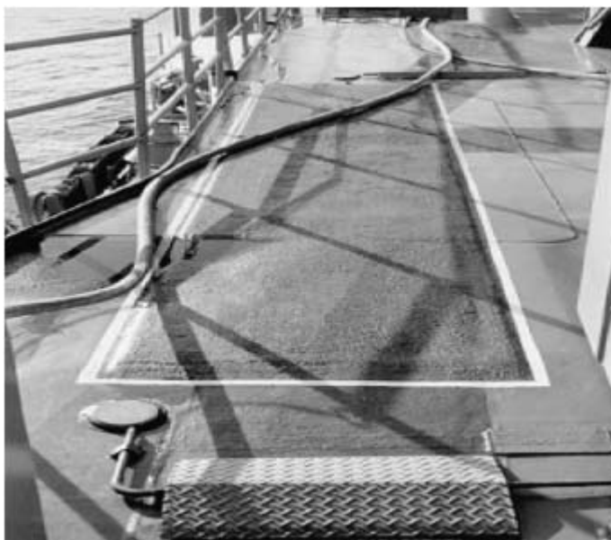
Σχήμα 4.6 Η ολοκληρωμένη επισκευή επί του καταστρώματος του HMAS Sydney.
