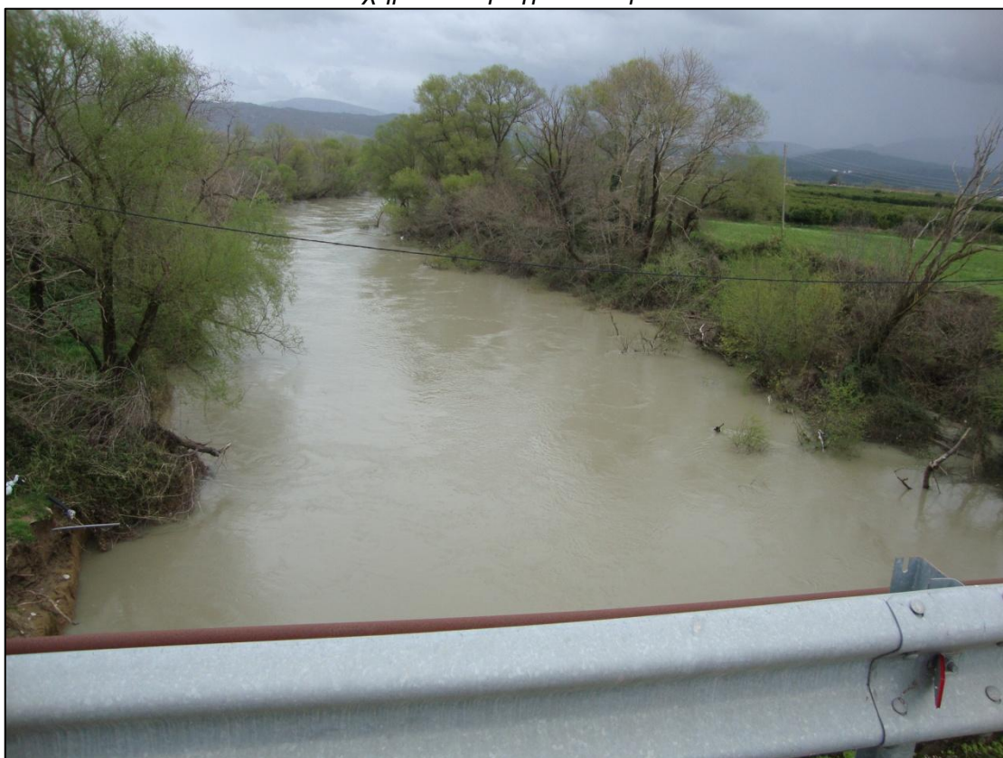
Σχήμα 37. Τεχνητό τμήμα εκβολής Καλαμά
