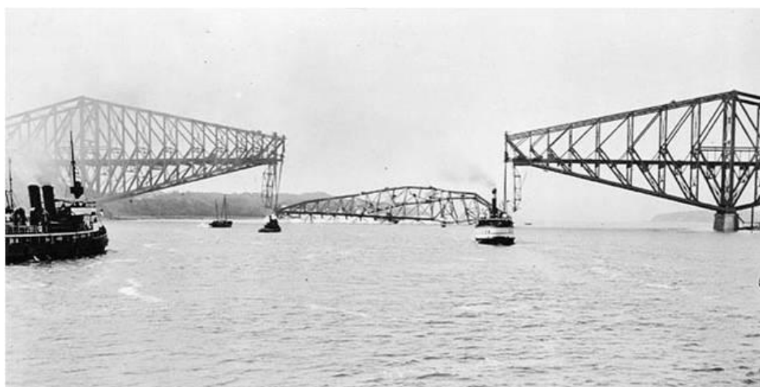
Σχήμα 2.1 Η Γέφυρα του Quebec στον Καναδά στην φάση κατασκευής.
