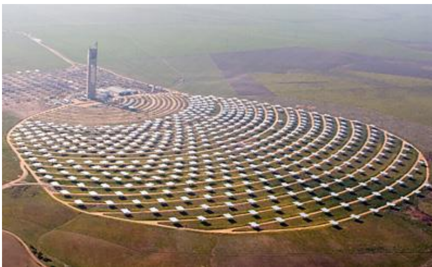
Σχήμα 3.1 Διάταξη Ηλιοστατικού Πεδίου Βόρεια του Πύργου PS10. [61]
