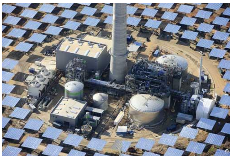
Σχήμα 2.16 Σύστημα αποθήκευσης θερμότητας δύο δεξαμενών (Gemasolar) [57]
