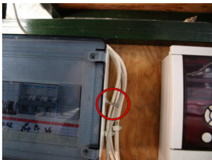
Σχήμα 4.16: Διακόπτης δύο θέσεων επιλογής της ταχύτητας του ανεμιστήρα
