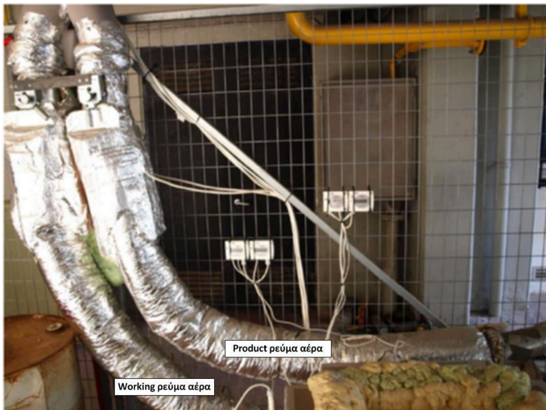
Σχήμα 4.12: Διάταξη αεραγωγών product working μετά το πρώτο παντελόνη
