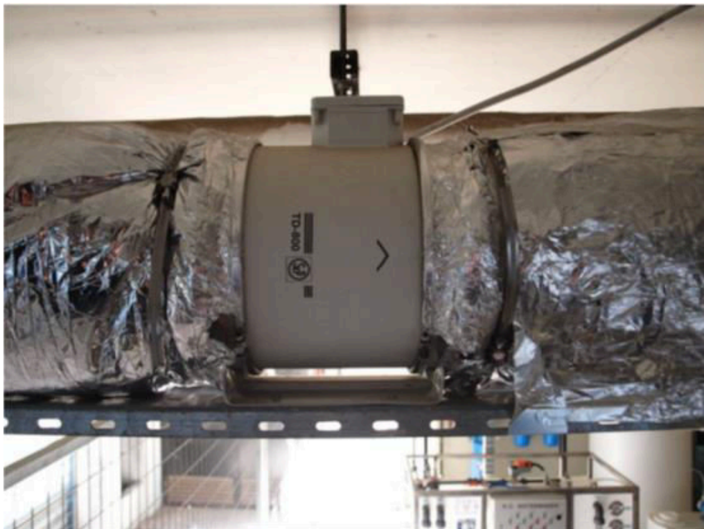
Σχήμα 4.3: Ηλεκτρικός κινητήρας απορρόφησης αέρα
