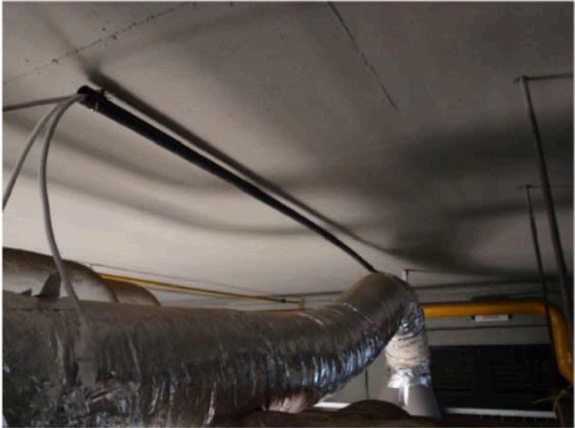
Σχήμα 4.7: Πλαστικός οδηγός σωλήνας καλωδίων – στήριγμα αεραγωγού
