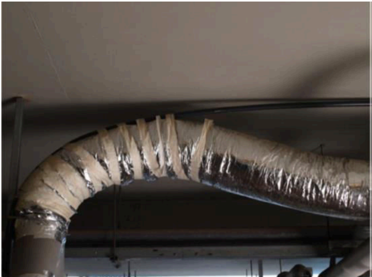
Σχήμα 4.8: Αμβλεία γωνία εύκαμπτου αεραγωγού
