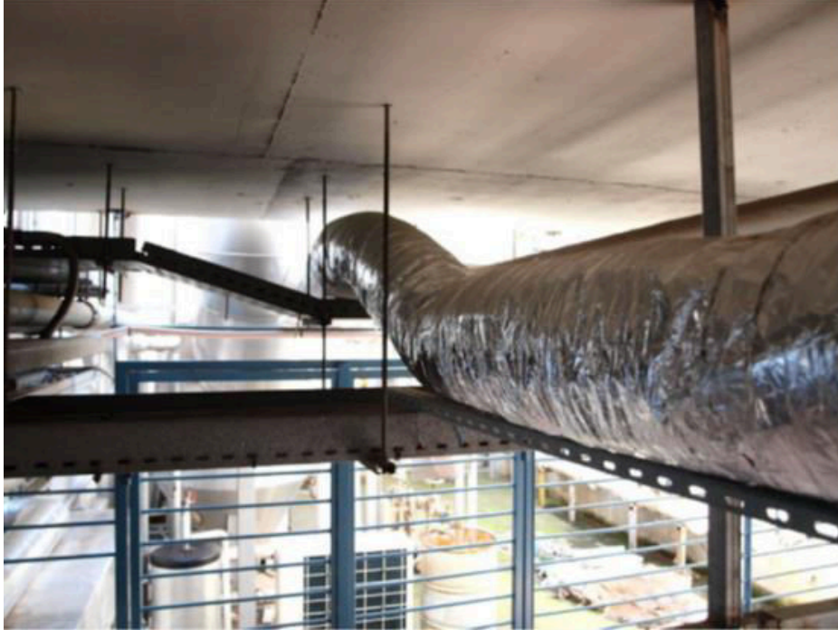
Σχήμα 4.4: Στήριξη εύκαμπτου αεραγωγού εισόδου κατά την είσοδο του αέρα περιβάλλοντος
