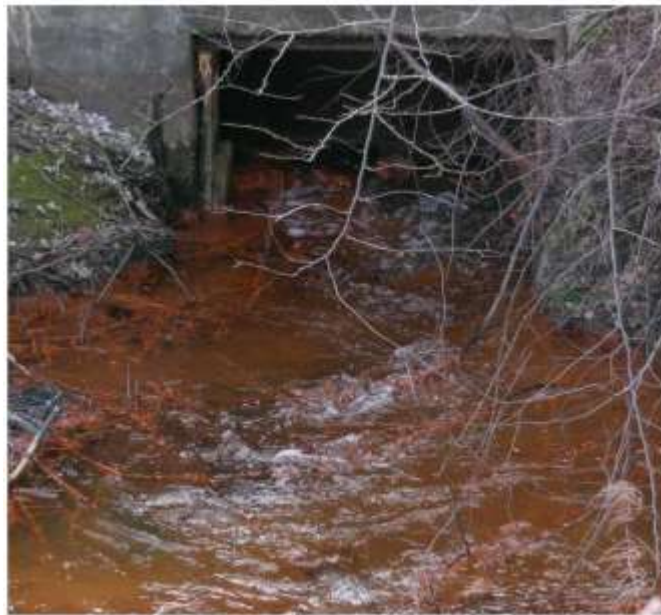
Εικόνα 1.3: Περιοχή που έχει πληγεί από την όξινη απορροή μεταλλείων (Ρεμουντάκη, 2012)
