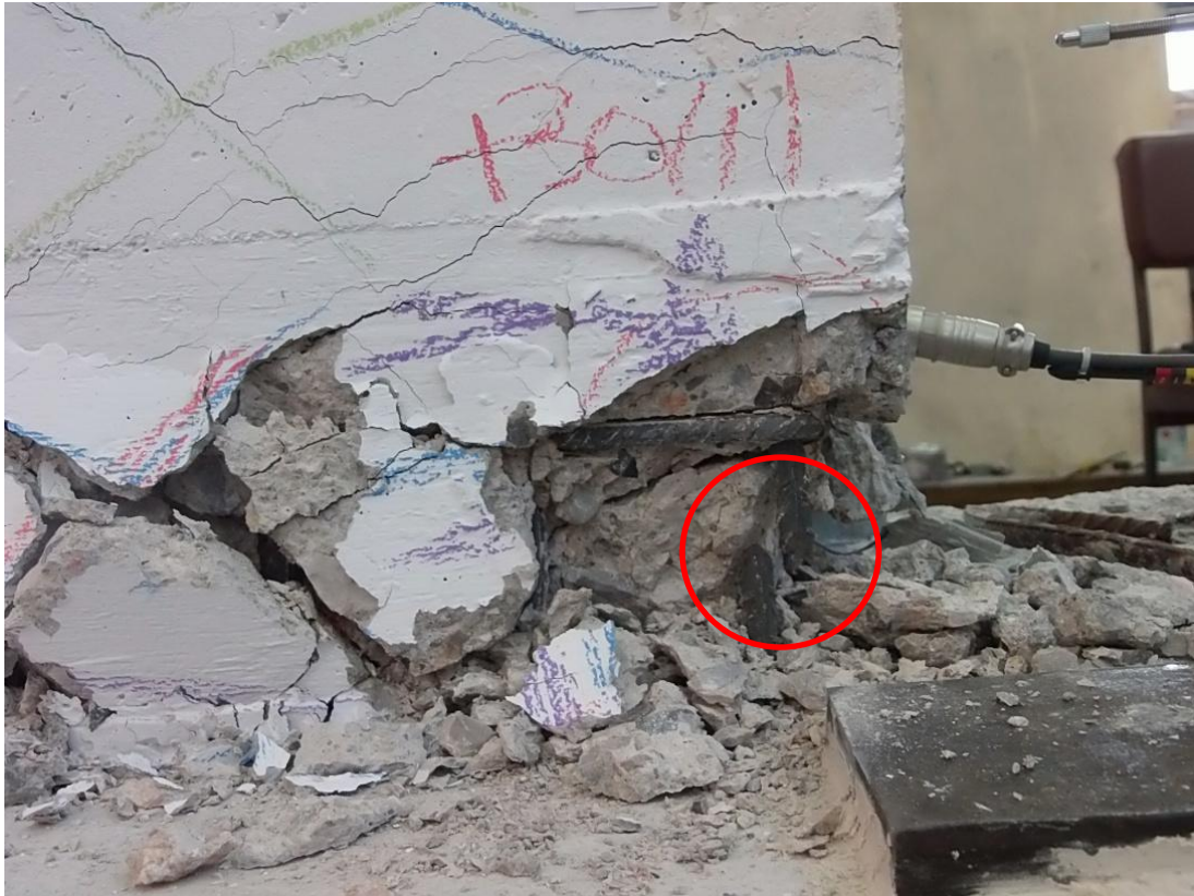
Εικόνα 5.7 Θραύση σε εφελκυσμό ακραίας ράβδου οπλισμού τοιχίου T7
