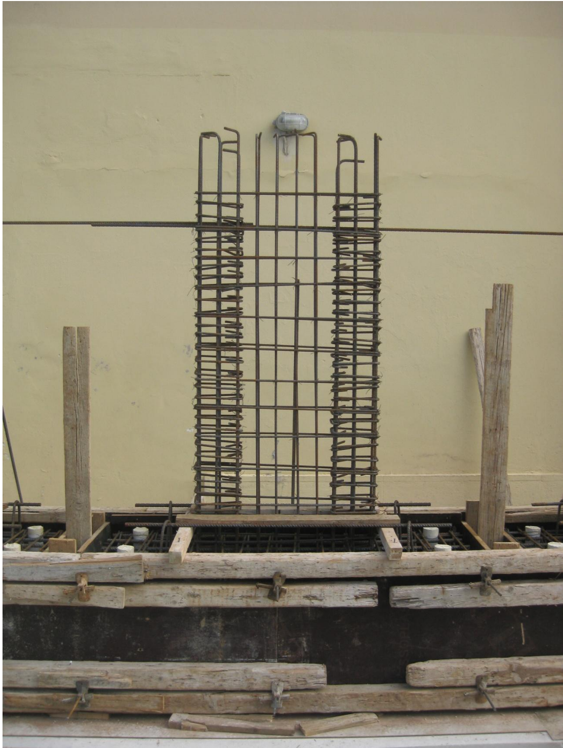
Εικόνα 3.3 Διαμόρφωση οπλισμού τοιχίου T7
