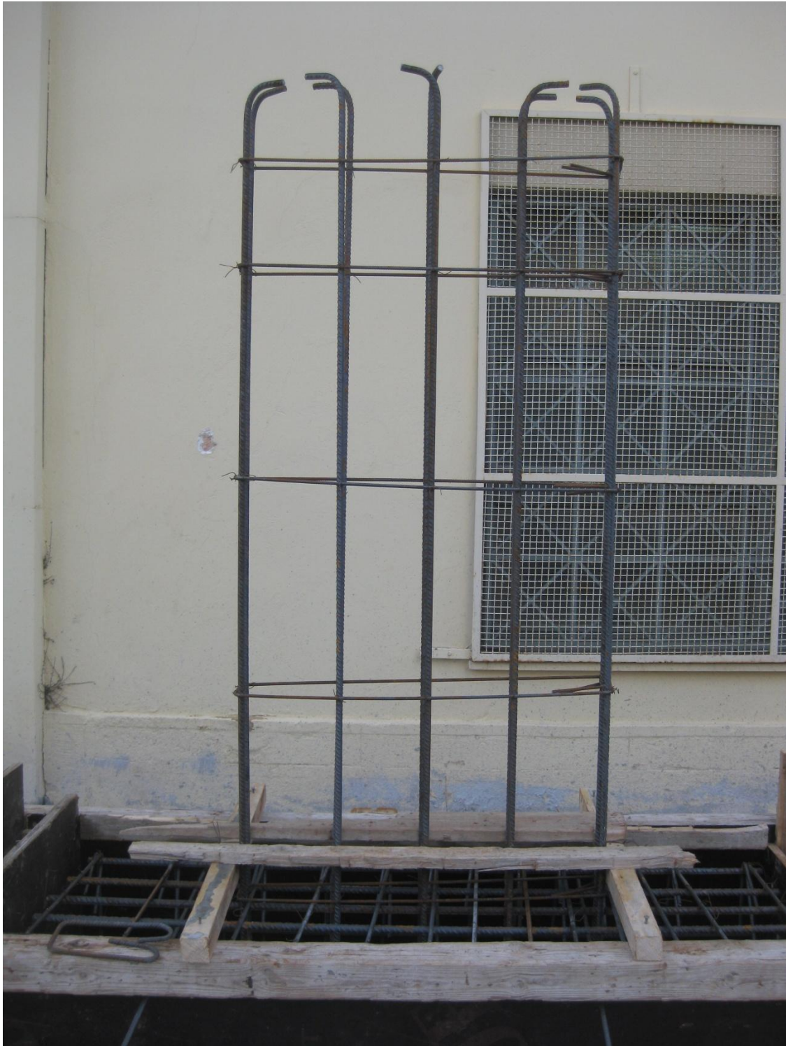
Εικόνα 3.8 Διαμόρφωση οπλισμού τοιχίου T12
