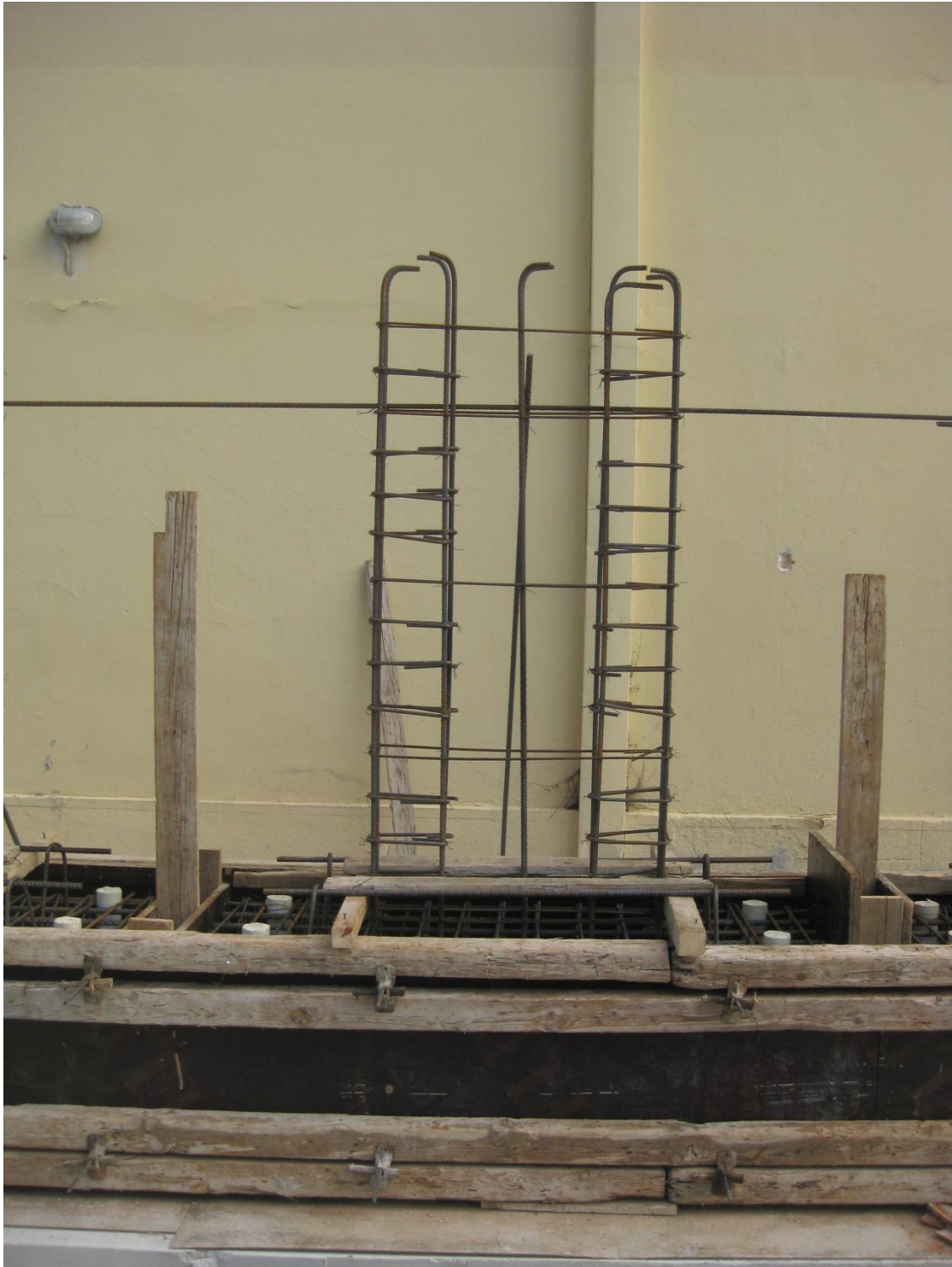
Εικόνα 3.7 Διαμόρφωση οπλισμού τοιχίου T11
