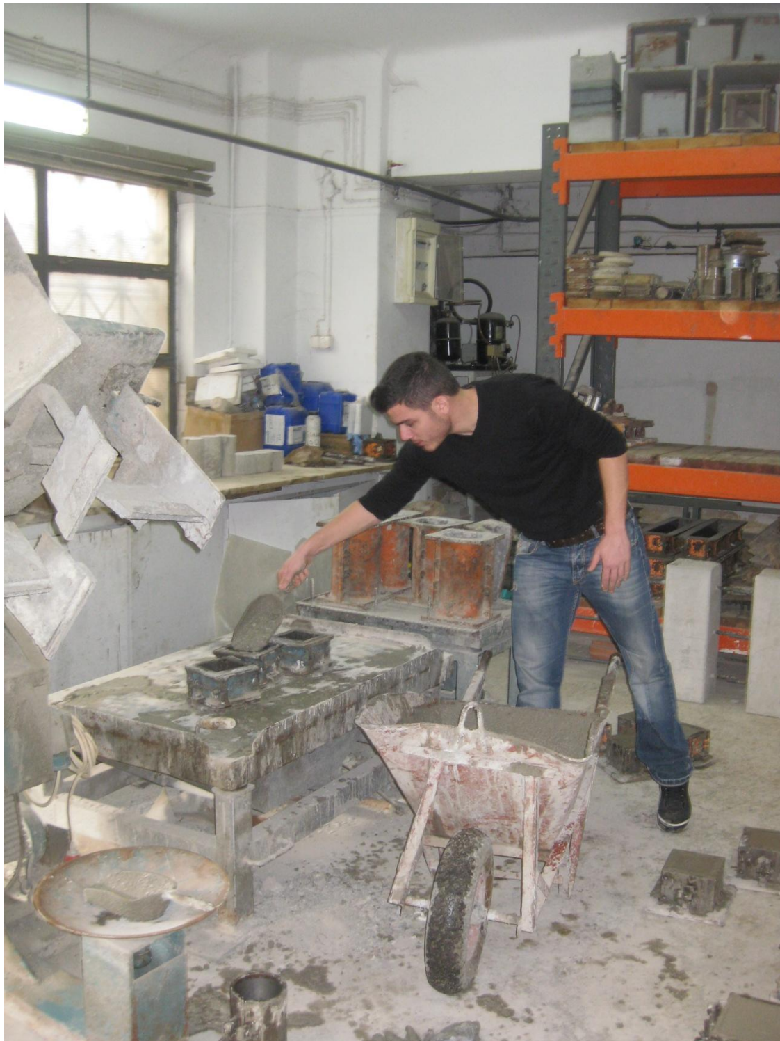
Εικόνα 3.9 Συλλογή σκυροδέματος τοιχίων σε μήτρες
