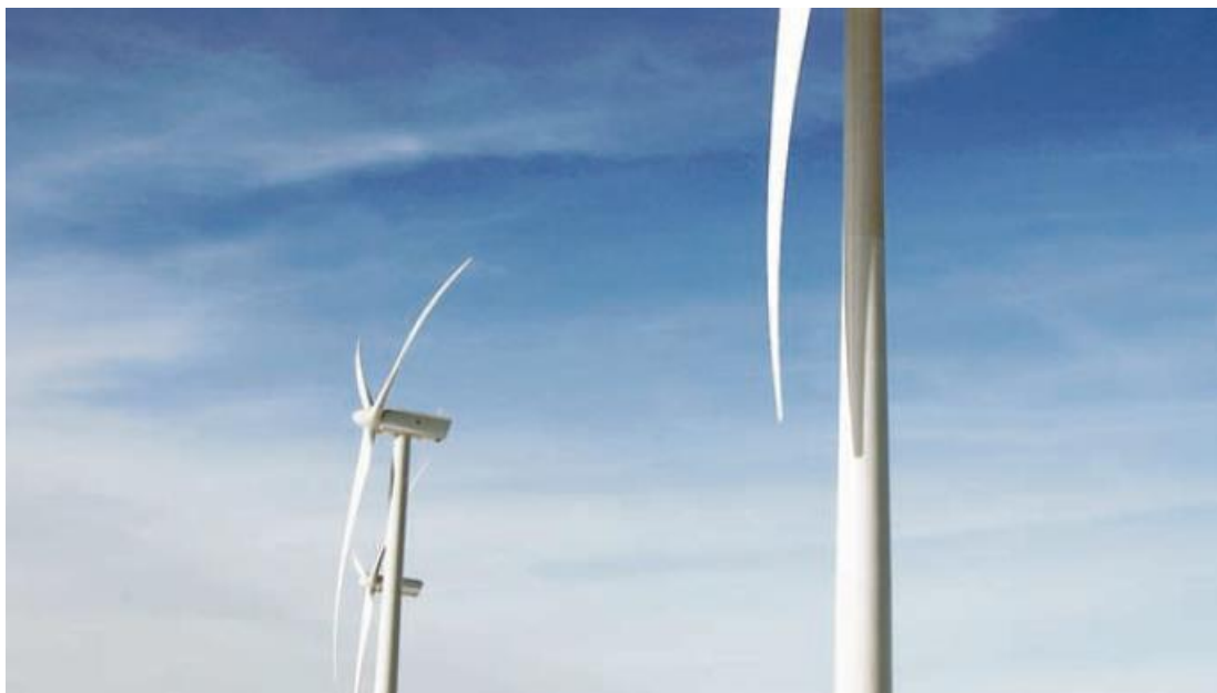
Σχήμα 3.9 Κάμψη πτερυγίων κατά flapwise [ Wind Turbine Blade Structural Engineering, WE Handbook, © Gurit ]
