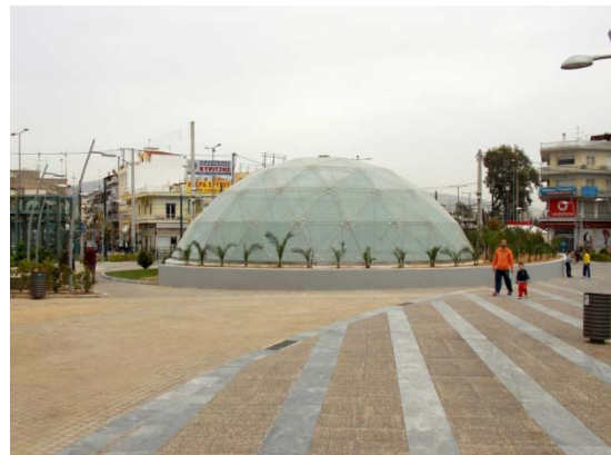
Εικόνα 2.29: Σταθμός μετρό Περιστέρι Πηγή: www.skyscrapercity.com
