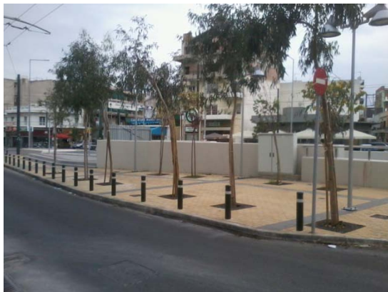
Εικόνα 2.28: Σταθμός μετρό Ανθούπολης Πηγή: Προσωπικό αρχείο
