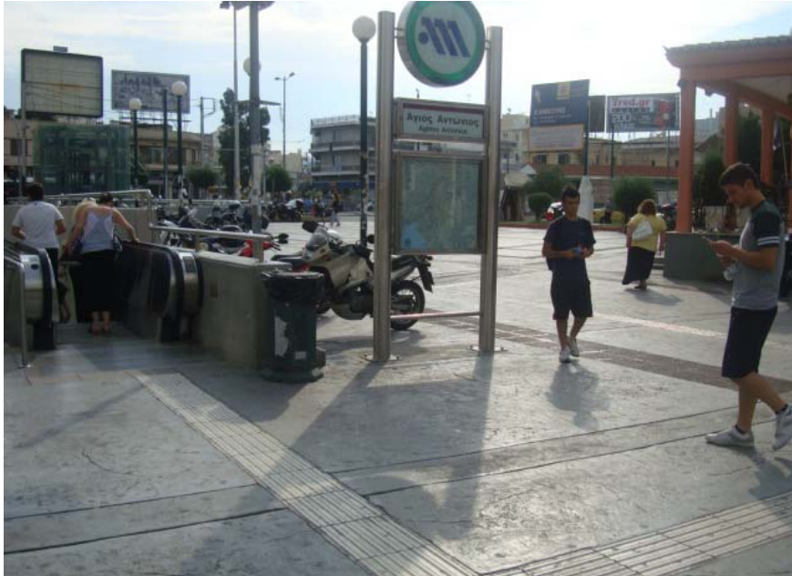
Εικόνα 2.30: Σταθμός μετρό Αγίου Αντωνίου
