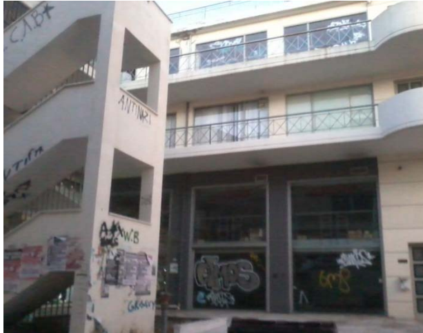
Εικόνα 2.15: Εγκαταλελειμμένο κτίριο του εμπορικού κέντρου του Περιστερίου Πηγή: Προσωπικό αρχείο
