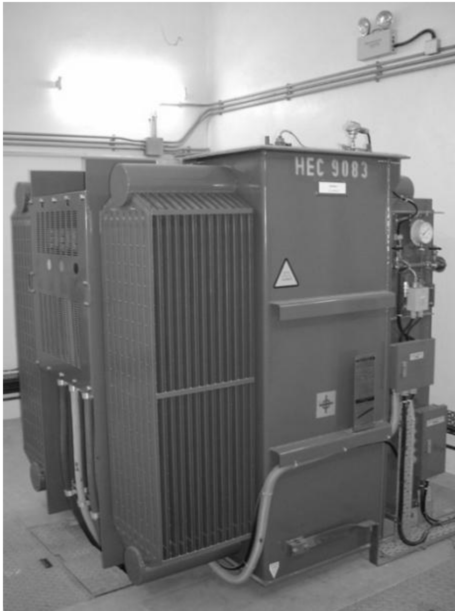
Εικόνα 5: Μετασχηματιστής ισχύος 1500 kVA με μόνωση SF 6 22kV / 390 V
