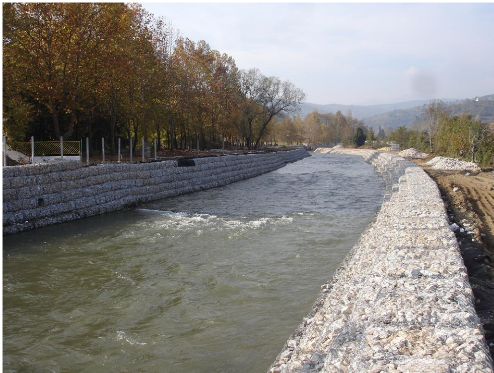
Εικόνα 2-18 : Χρήση συρματοκιβωτίων σε αντιπλημμυρικά έργα ποταμού ( www.panmetal.gr )
