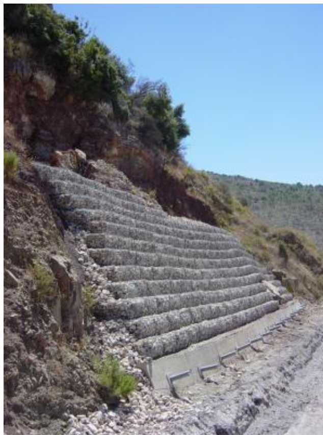
Εικόνα 2-16 : Χρήση συρματοκιβωτίων για στεθεροποίηση ασταθούς πρανούς ( www.choromonotiki.gr )
