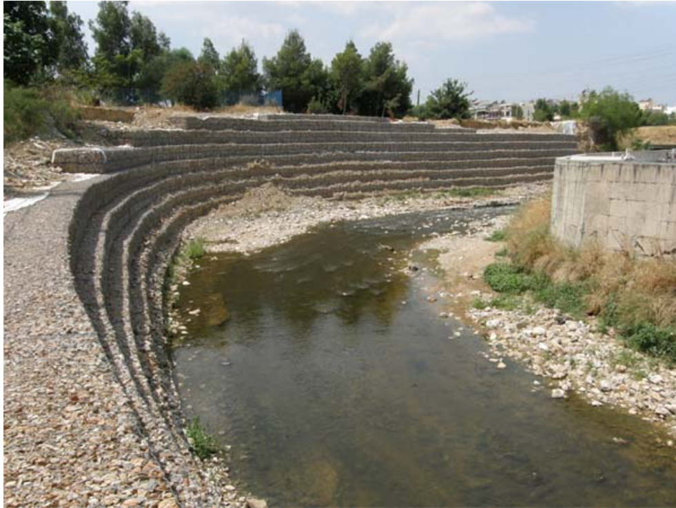
Εικόνα 2-19 : Εργασίες αντιστήριξης των πρανών του ποταμού Κηφισού ( www.choromonotiki.gr )
