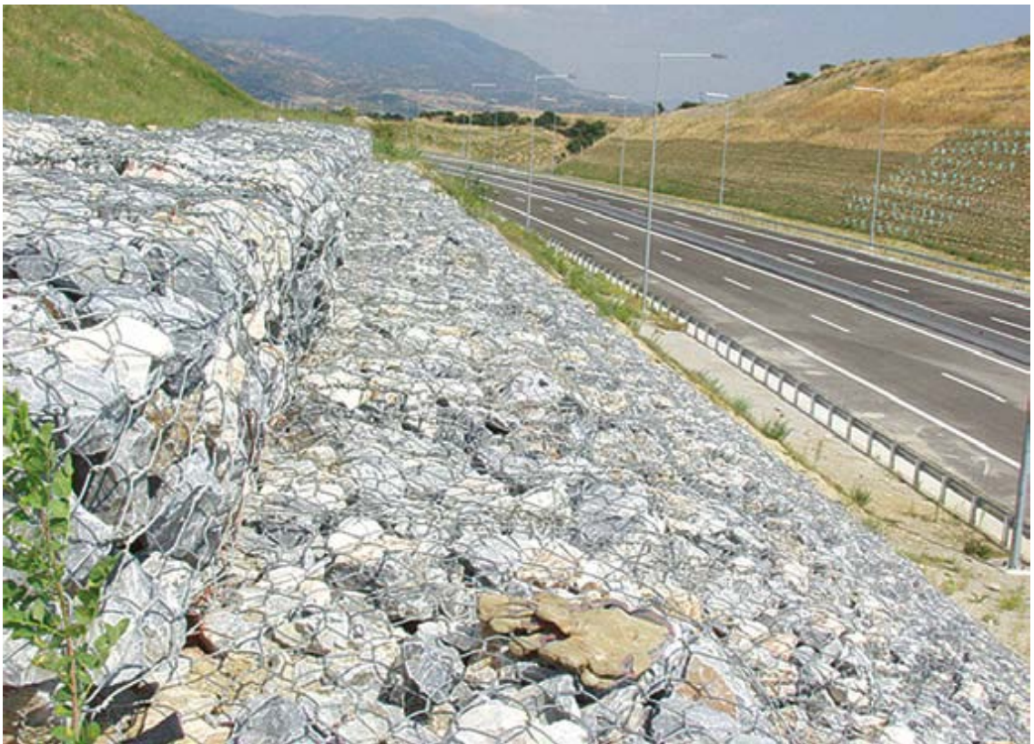
Εικόνα 2-5 : Χαρακτηριστικά παραδείγματα εφαρμογών ημιεύκαμπτων επενδύσεων επιχωμάτων ( www.Panmetal.gr )
