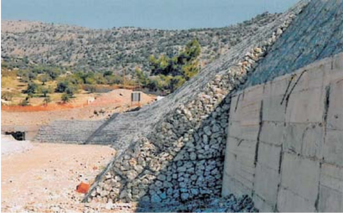
Εικόνα 2-6 : Χαρακτηριστικά παραδείγματα εφαρμογών ημιεύκαμπτων επενδύσεων επιχωμάτων ( www.Panmetal.gr )
