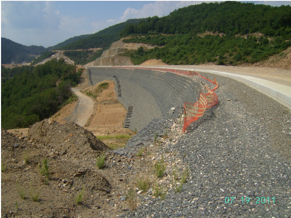
Εικόνα 2-12 : Οπλισμένο επίχωμα 27-28 κάθετου άξονα Κομοτηνή –Ελληνοβουλγαρικά σύνορα
