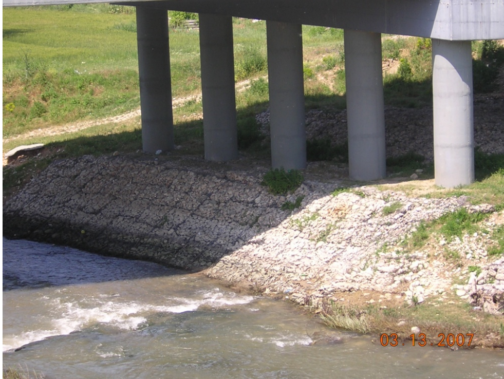
Εικόνα 2-17 : Χρήση συρματοκιβωτίων για επένδυση θεμελίωσης γέφυρας ( www.choromonotiki.gr )
