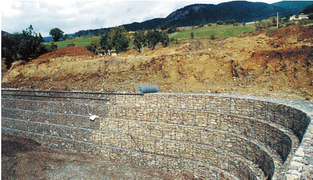
Εικόνα 2-8 : Παράδειγμα εφαρμογής οπλισμένου επιχώματος με συρματοκιβώτια σε πρανές μέσου ύψους ( www.choromonotiki.gr )
