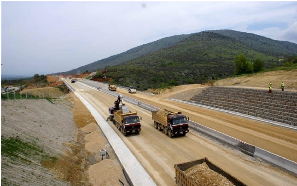
Εικόνα 2-14 : Χρήση συρματοκιβωτίων για επένδυση πρανών ( www.egnatia.gr )
