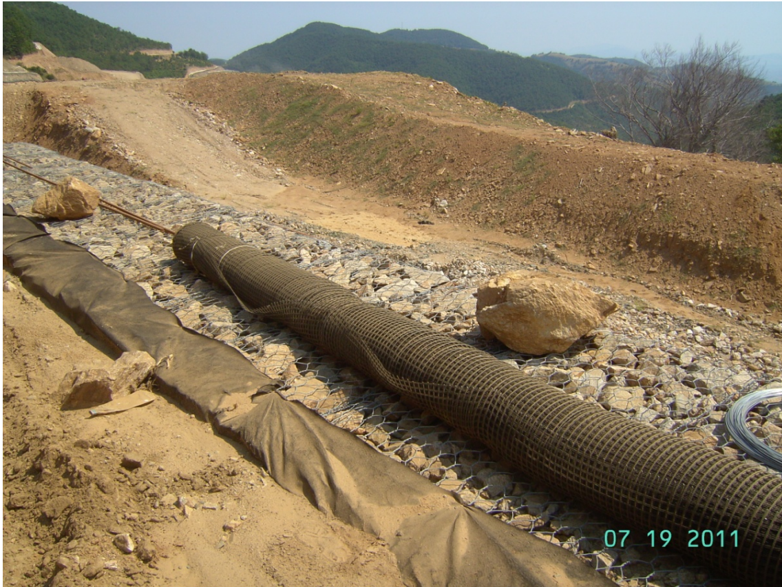
Εικόνα 3-6 : Διαδικασία κατασκευής συρματοκιβωτίων επιχώματος 27-28
