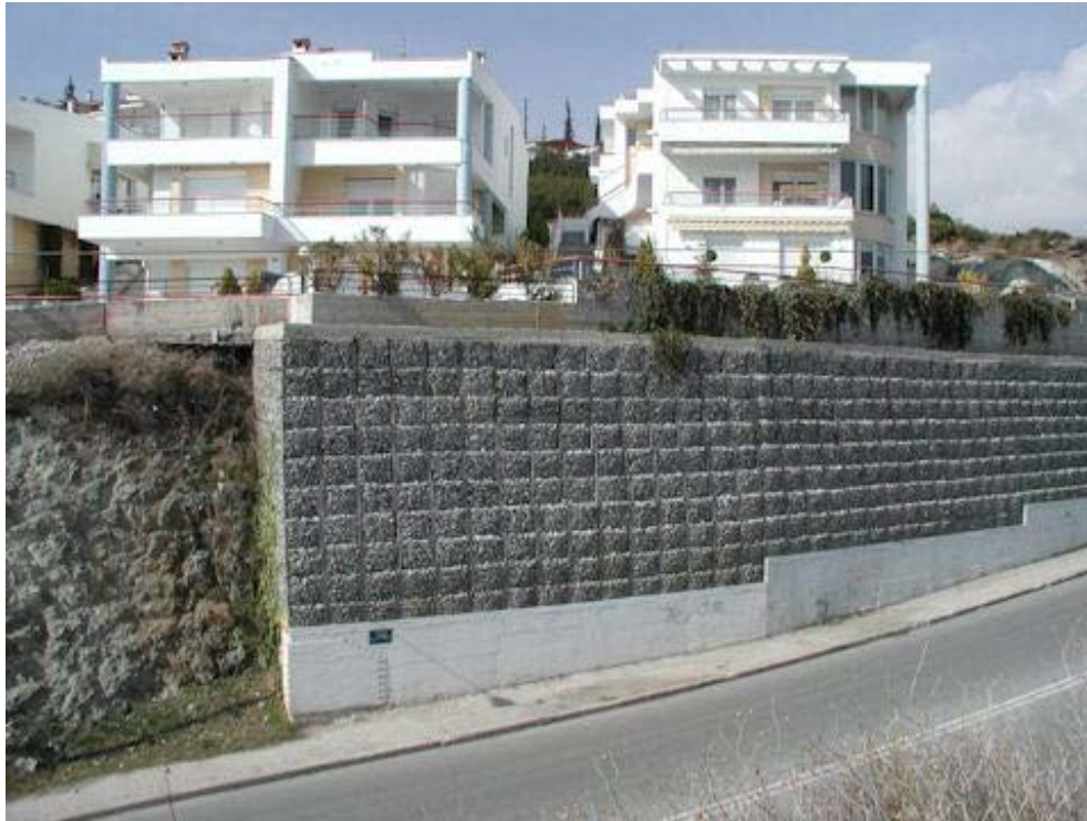
Εικόνα 2-15 : Χρήση συρματοκιβωτίων για επένδυση πρανών ( www.geognosi.gr )
