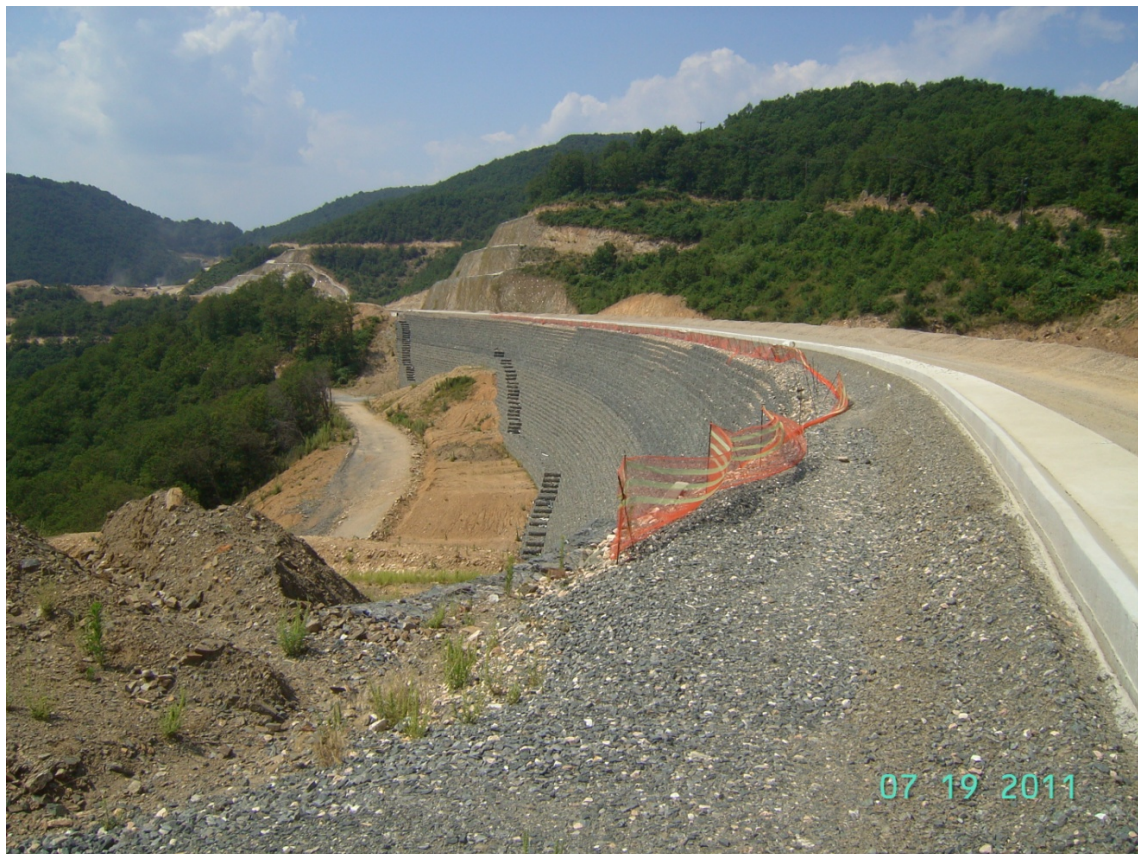
Εικόνα 3-4 : Χαρακτηριστική άποψη επιχώματος 27-28
