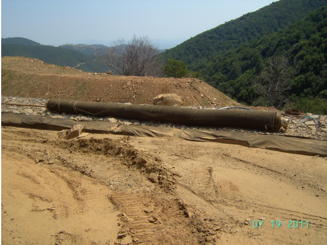
Εικόνα 3-8 : Διαδικασία τοποθέτησης συρματοκιβωτίων επιχώματος 27-28
