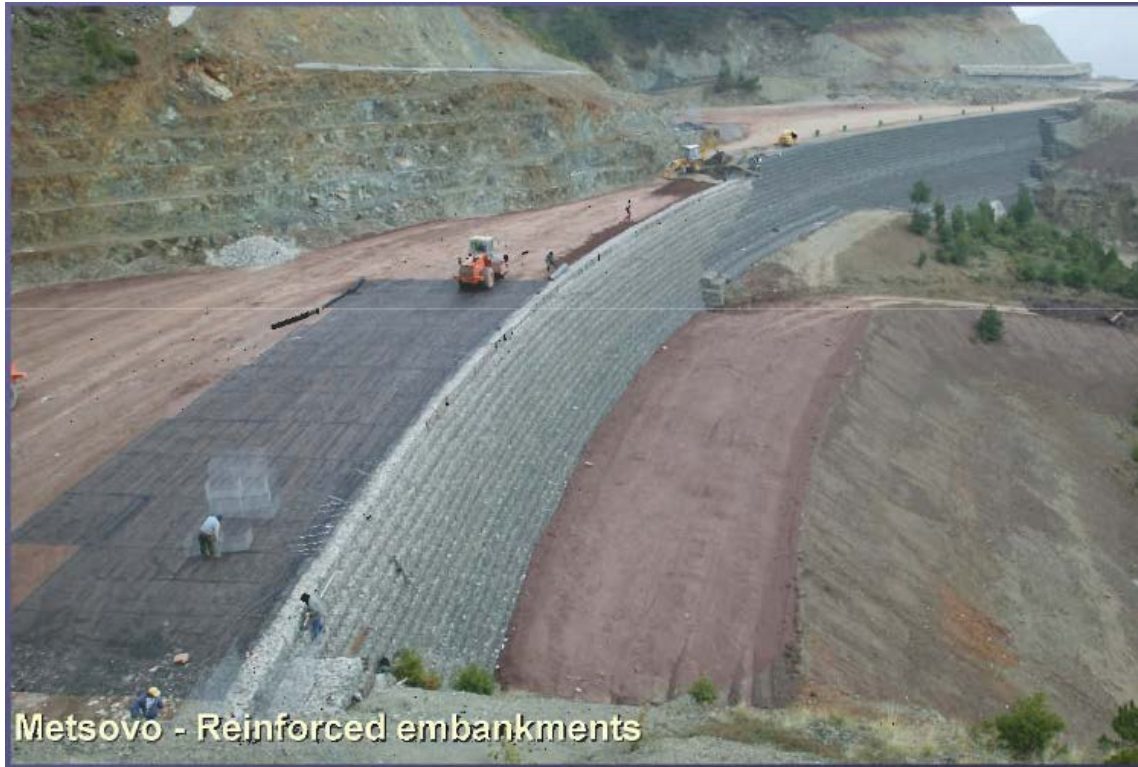
Εικόνα 2-13 : Παραδείγμα οπλισμένων επιχωμάτων σε έργα οδοποιίας, Μέτσοβο ( www.geognosi.gr )
