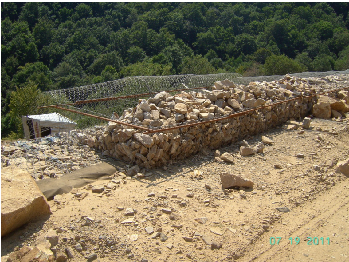
Εικόνα 3-7 : Διαδικασία πλήρωσης συρματοκιβωτίων επιχώματος 27-28
