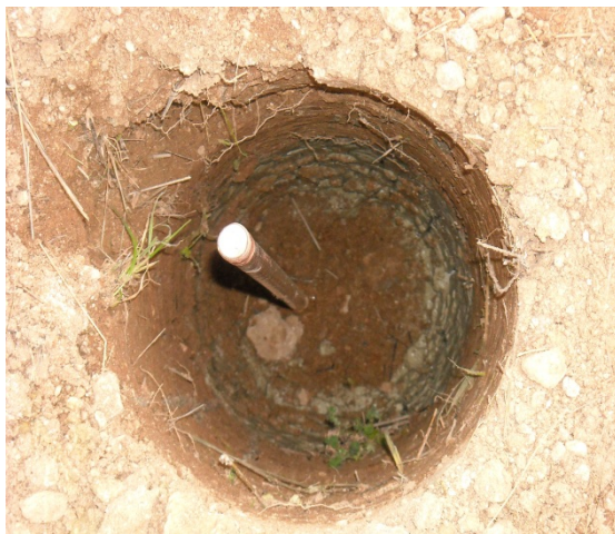
Εικόνα 5.4: Τοποθέτηση ηλεκτροδίων.
