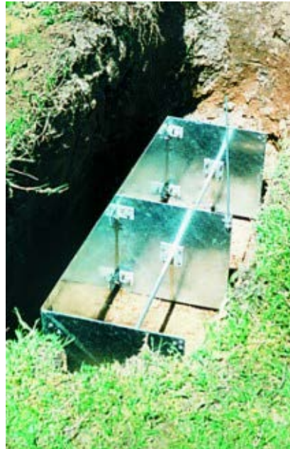
Εικόνα 1.1: Εγκατάσταση γειωτή τύπου “E”.
