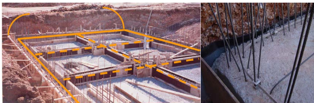
Εικόνα 1.2: Εφαρμογή σε δομική κατασκευή.
