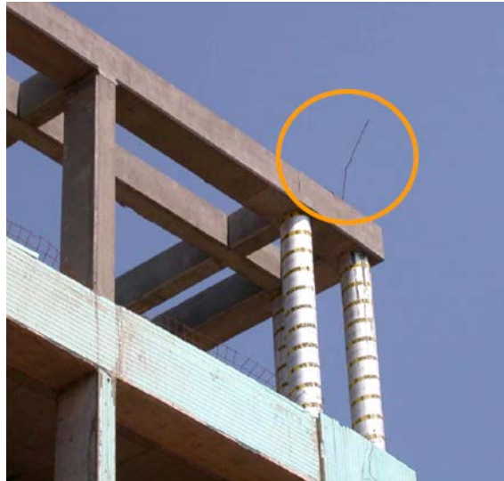
Εικόνα 1.3: Εφαρμογή θεμελιακής γείωσης ως ΣΑΠ.
