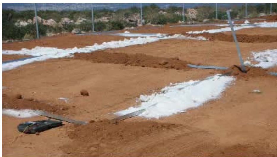
Εικόνα 4.2: Πλέγμα γείωσης εγκιβωτισμένο σε αλάτι.
