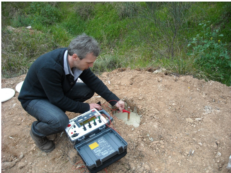
Εικόνα 5.10: Σύνδεση του γειωσόμετρου σε ηλεκτρόδιο γείωσης.
