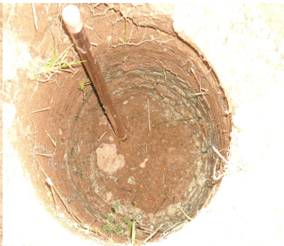
Εικόνα 5.4: Τοποθέτηση ηλεκτροδίων.
