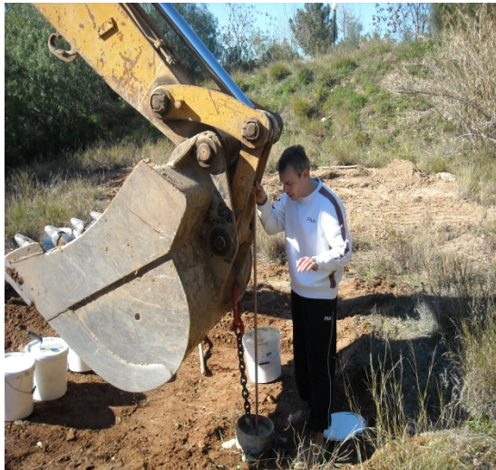
Εικόνα 5.3: Διάνοιξη οπών με εκσκαφέα βαρέως τύπου.
