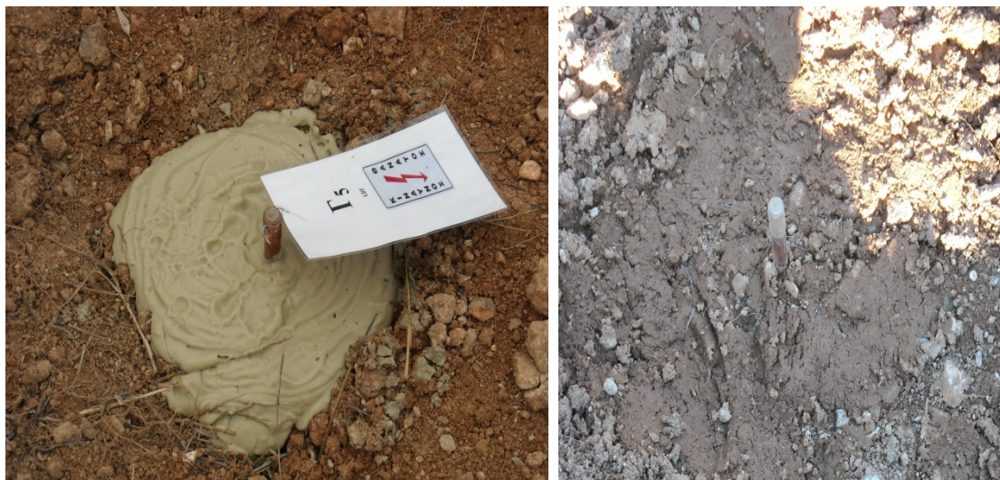
Εικόνα 5.5: Ηλεκτρόδια γείωσης εμβαπτισμένα σε βελτιωτικά υλικά εδάφους.
