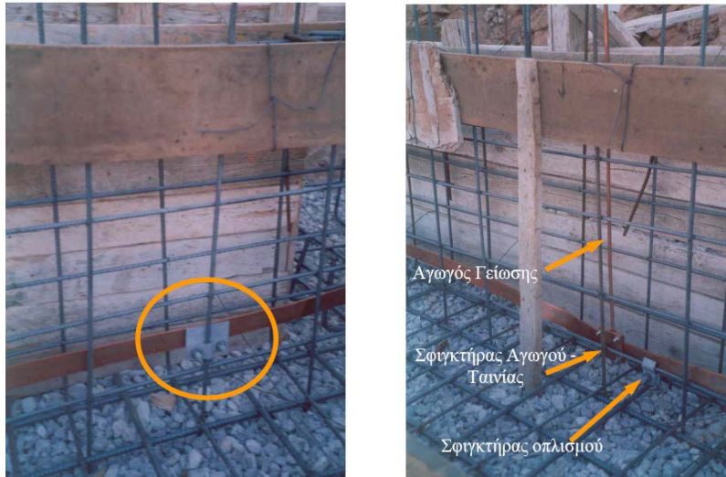
Εικόνα 1.4: Κατασκευαστικές λεπτομέρειες θεμελιακής γείωσης.
