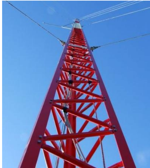
Εικόνα 2.2: Δικτυωτός μετεωρολογικός ιστός.
