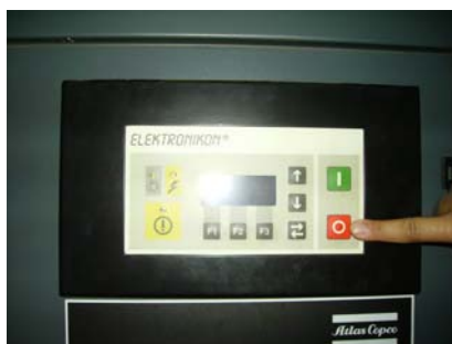
Σχήμα 2.13. Ο συμπιεστής του αέρα κλειστός.
