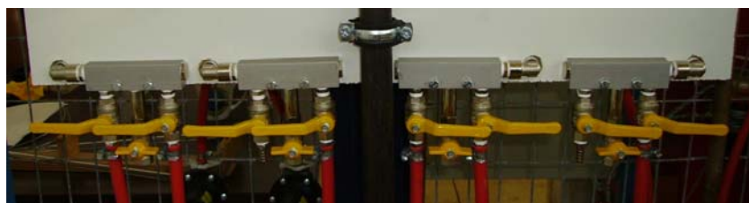
Σχήμα 2.9. Σφαιρικές βαλβίδες.
