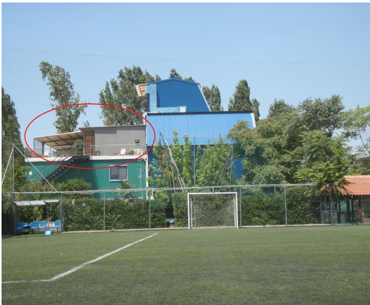
2.1 Όψη των 2 κτιρίων (σημ. υπήρξε μετέπειτα επέκταση στην οροφή του κτιρίου Α)
