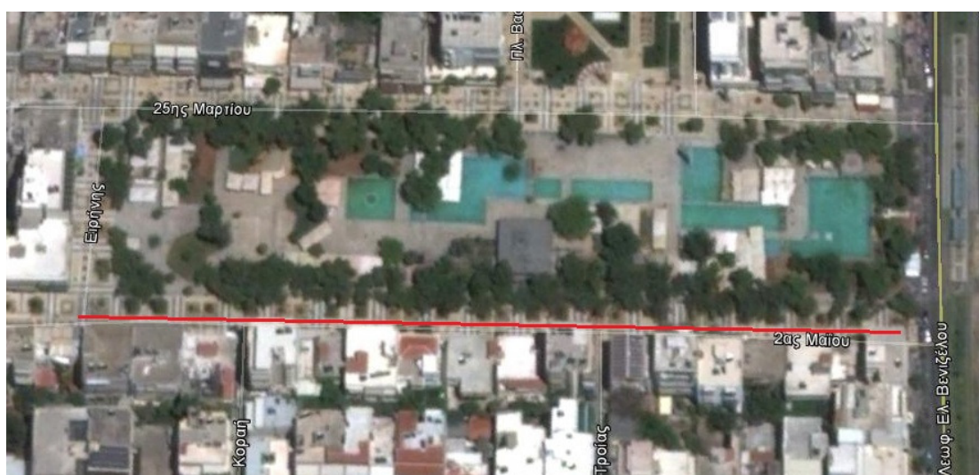
Εικ. 8.5 - Μερική άποψη του πεζόδρομου 2ας Μαΐου από ύψος 351 m
