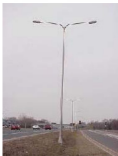
Εικ. 3.3 – Ιστοί φωτισμού με διπλό ή δίδυμο βραχίονα (αριστερά) και φωτισμός επί υψηλών ιστών (δεξιά)
