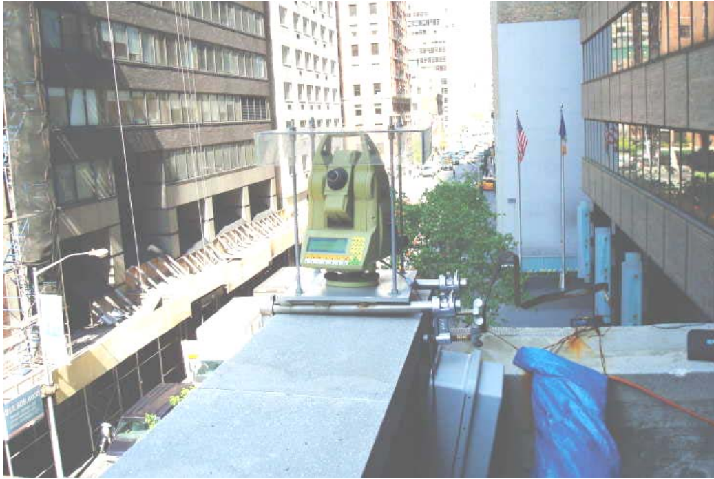
Εικόνα 54: Παρακολούθηση μικρομετακινήσεων κτιριακών εγκαταστάσεων (Manhattan, New York)
