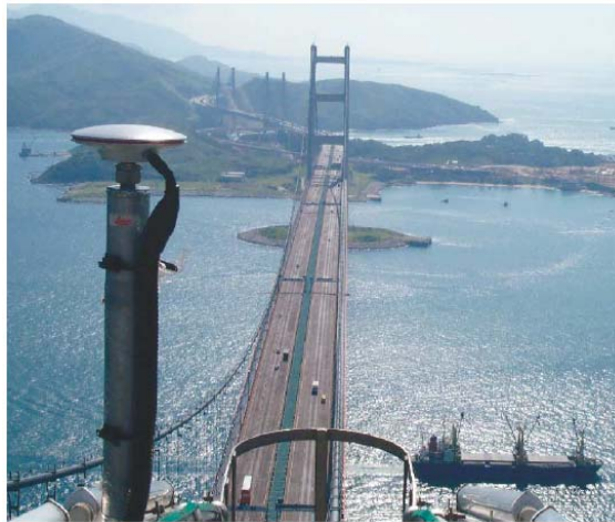
Εικόνα 13: Δέκτης GPS τοποθετημένος στην κορυφή ενός πυλώνα της γέφυρας Tsing Ma. Στο βάθος η γέφυρα Kap Shui Mun
