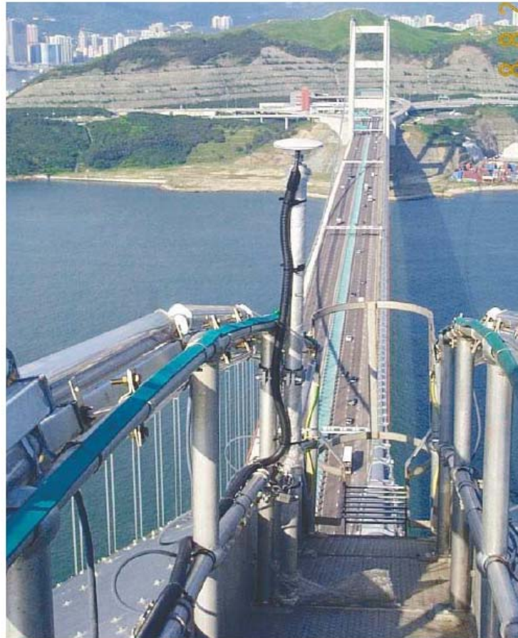
Εικόνα 15: Δέκτης GPS τοποθετημένος στη γέφυρα Tsing Ma.
