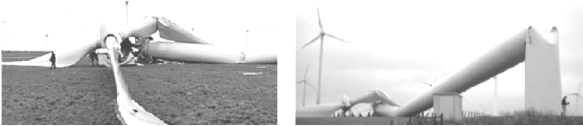
Εικόνα 6: Ολική κατάρρευση ανεμογεννήτριας Picture 6: Total collapse of the wind generator
