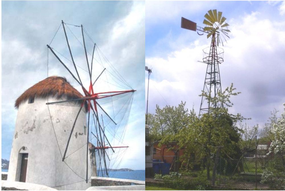
Εικόνα 1: Παραδοσιακός ανεμόμυλος και αργή αιολική μηχανή Picture 1: Traditional windmill and slow wind machine
