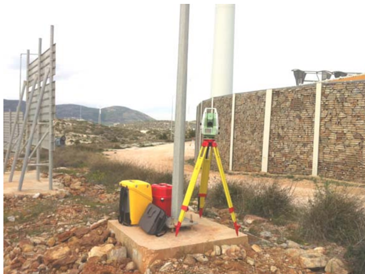
Εικόνα 43: Ο γεωδαιτικός σταθμός TM30
