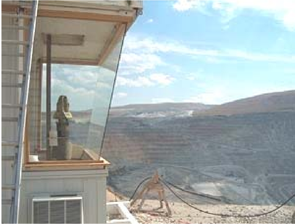
Εικόνα 52: Παρακολούθηση εκσκαφής λατομείου (British Columbia, Canada)
