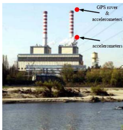
Εικόνα 18: Όψη των καπνοδόχων με τις θέσεις του GPS και των επιταχυνσιόμετρων
