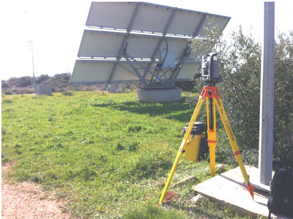
Εικόνα 45: Ο γεωδαιτικός σταθμός Trimble VX
