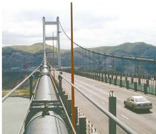
Εικόνα 14: Δέκτης GPS τοποθετημένος στη γέφυρα Tsing Ma.
