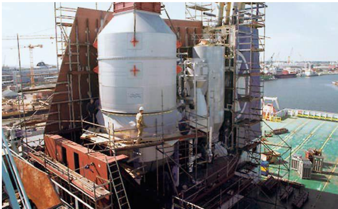
Εικόνα 9. Κατά την εκτέλεση των εργασιών
