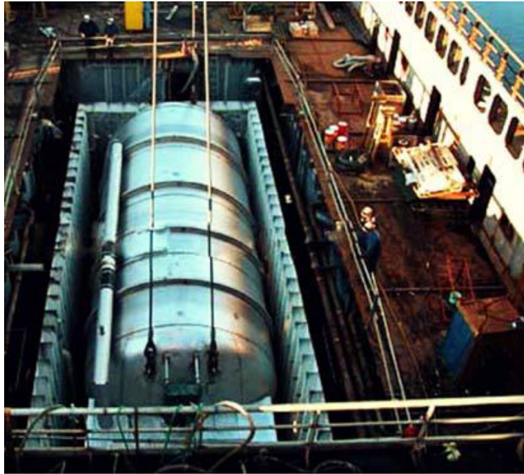
Εικόνα 33. Τοποθέτηση φορητής δεξαμενής LNG
