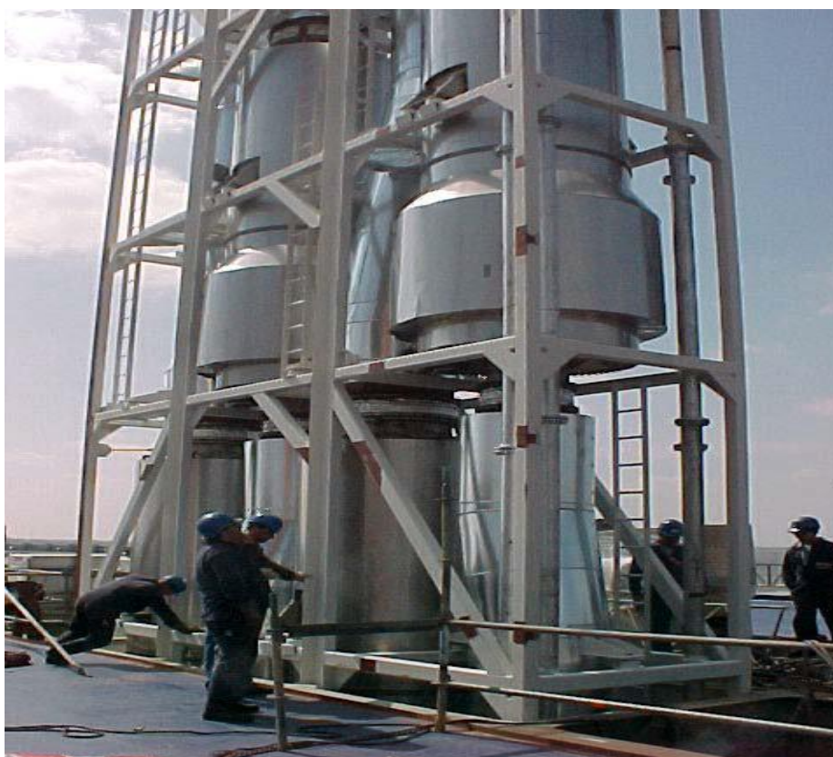
Εικόνα 11. Τοποθέτηση Scrubber
