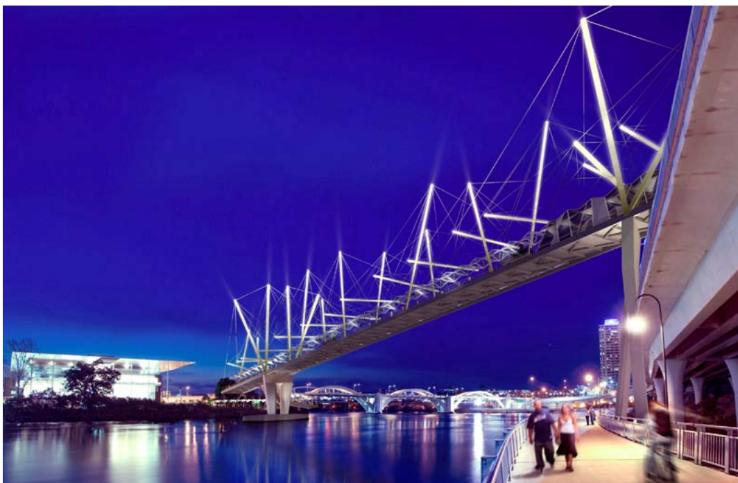
Σχήμα 5.2: Παράδειγμα σύνθετης ελαστομερούς κατασκευής
