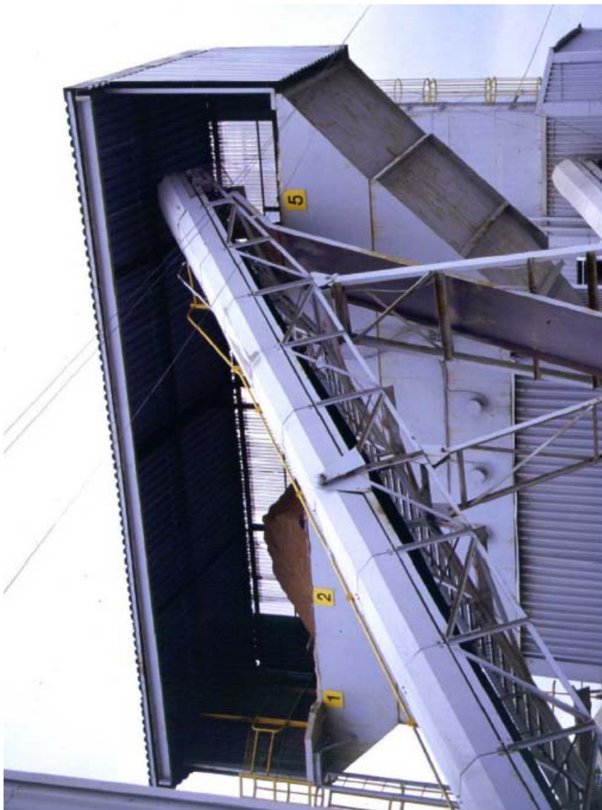
Σχήμα 2: Γραμμή μεταφοράς μετά την αφύγρανση των υλικών σύνθεσης του σκυροδέματος
