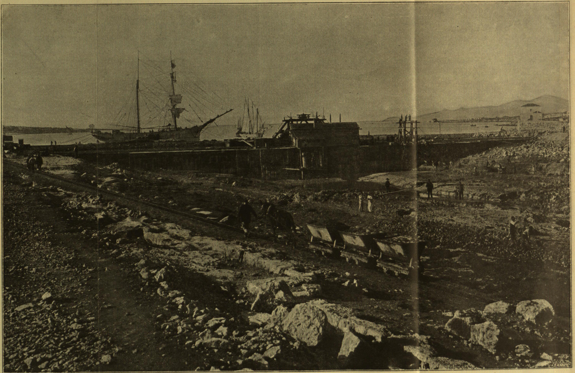
Δεξαμενὰ ἐπισκευῆς. Ἐσωτερικὴ ἀποψὶς τοῦ φράγματος.
